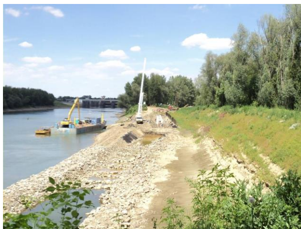
17. kép. Torkolati szakasz kivitelezése úszóműről
