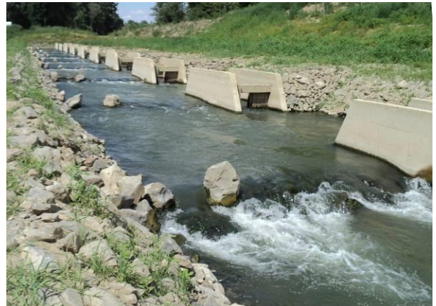
12. kép. Az alsó szakasz 10 db kőküszöb, réselt halátjáró kombinációja
