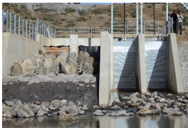
4 kép. A durva rámpa és a tápláló zsilip beüzemelés közben
