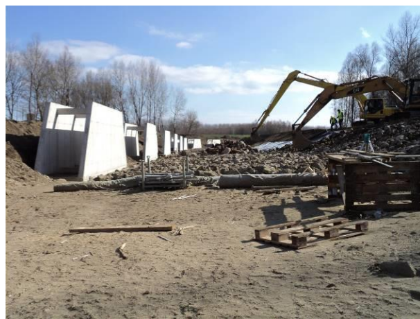
10. kép. Kőküszöbök, mederfenék kialakítása geotextília ágyon
