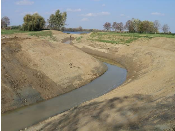
1. kép. Tápcsatorna feltöltés előtt
