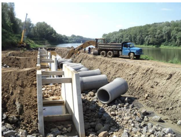
14. kép. Épülő csalívíz csatorna, réselt halátjáró és kőküszöb
