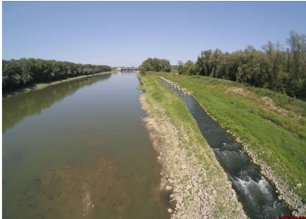
11. kép. A hallépcső alsó torkolati szakasza. Távolban a Kiskörei Vízlépcső
