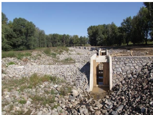
7. kép. Elkészült kőküszöbök, réselt halátjárók
