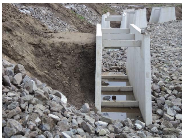
9. kép. Réselt halátjáró csatlakozása a bal parthoz
