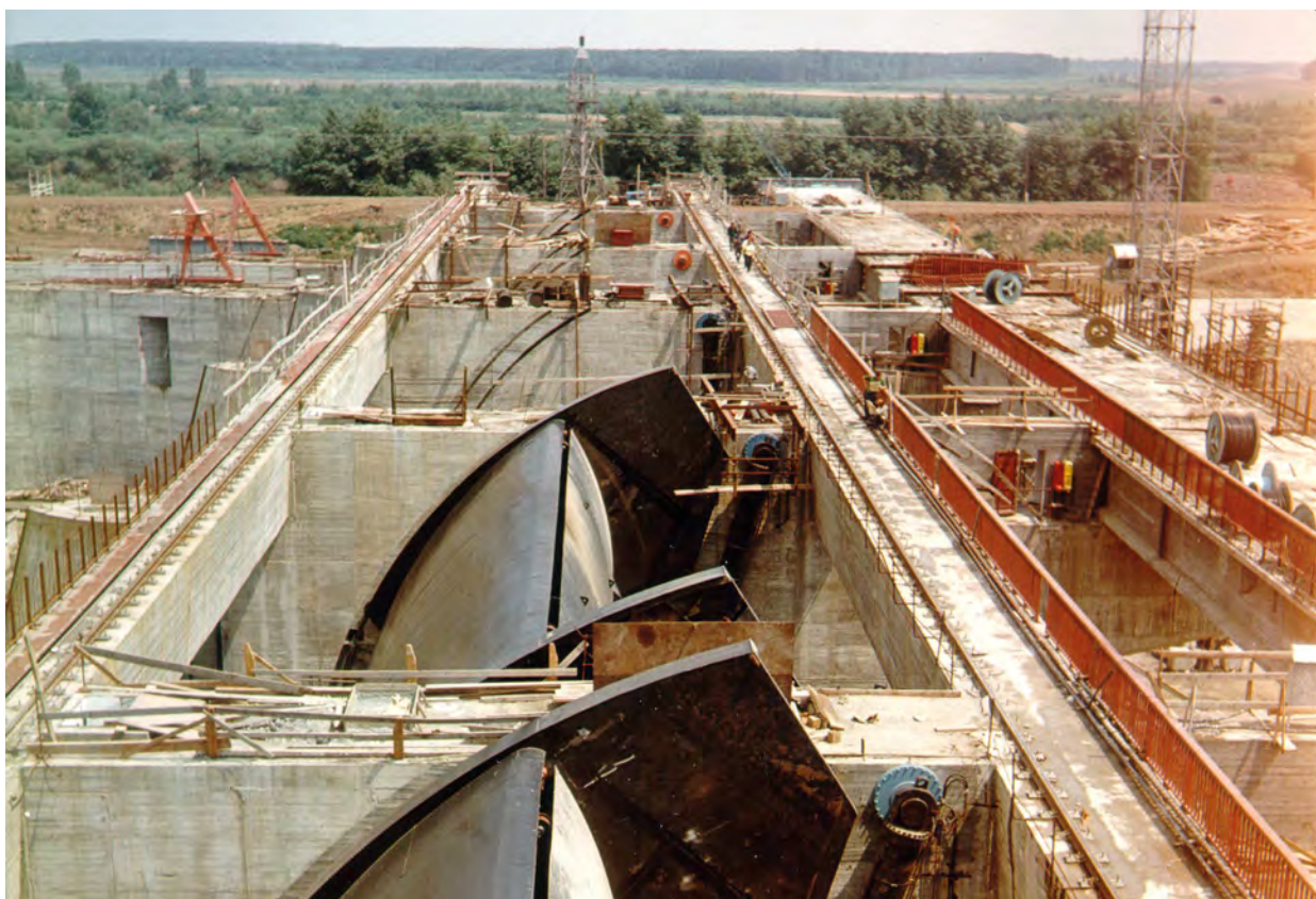
Archív fotó a szegmenstáblák szereléséről
