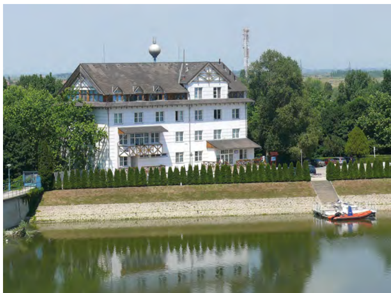
A Kiskörei Szakaszmérnökség a duzzasztómű átadásának évében, 1973-ban jött létre, az irodaépülete is akkor létesült
