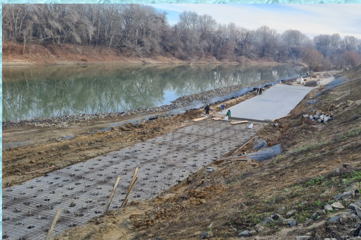
A vasbeton plató vasszerelési és betonozási munkái
