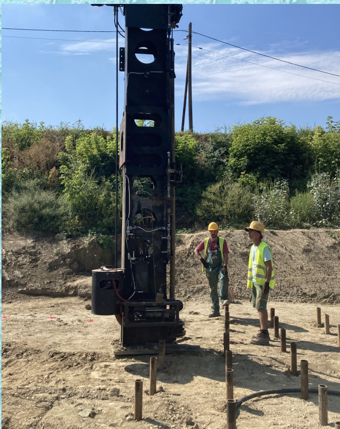
Georudak sajtolása 18 méter mélységbe
