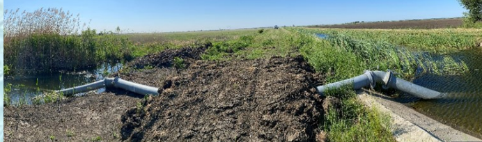
Nk-III-2-6. fűrtfőcsatornán kiépített szivornya
