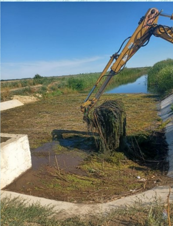
Uzsadék eltávolítás az NK-III-2. fűrtfőcsatornán
