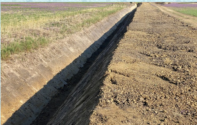
Karcagi I-13. csatorna vízpótlását biztosító Karcag 02309 hrsz-ú csatorna kotrás után
