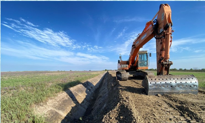
Karcagi I-13. csatorna vízpótlását biztosító Karcag 02309 hrsz-ú csatorna kotrás közben
