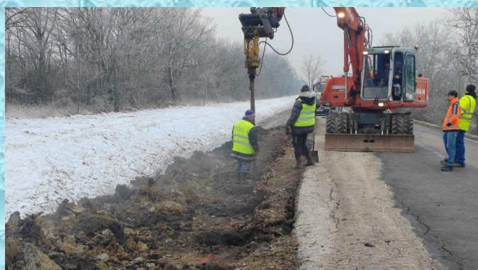
Vasbeton cölöpsor furatainak elkészítése
