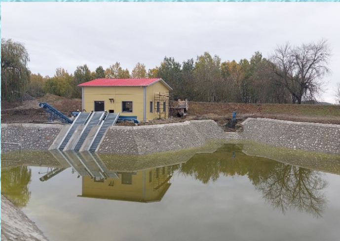
Az új Gástyás II. szivattyútelep
