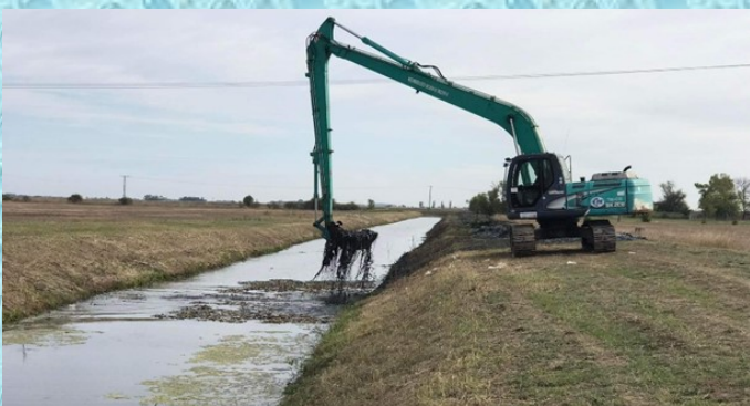
A Karcagi III. belvíz főcsatorna kotrása
