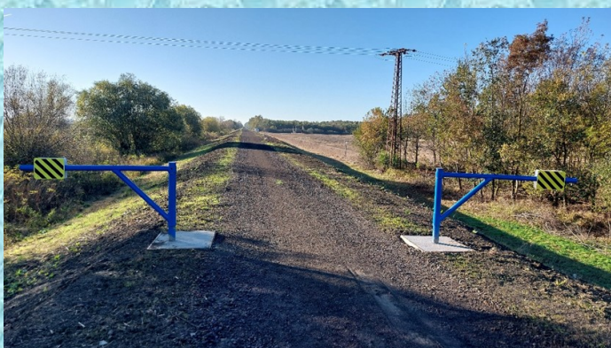
Elkészült a szivattyútelepet megközelítő út a Hortobágy-Berettyó főcsatornán
