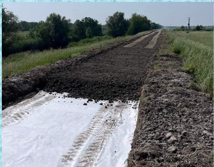
Hortobágy- Berettyó fcs. árvízvédelmi töltésének zúzott kőes töltéskorona stabilizáció készítése
