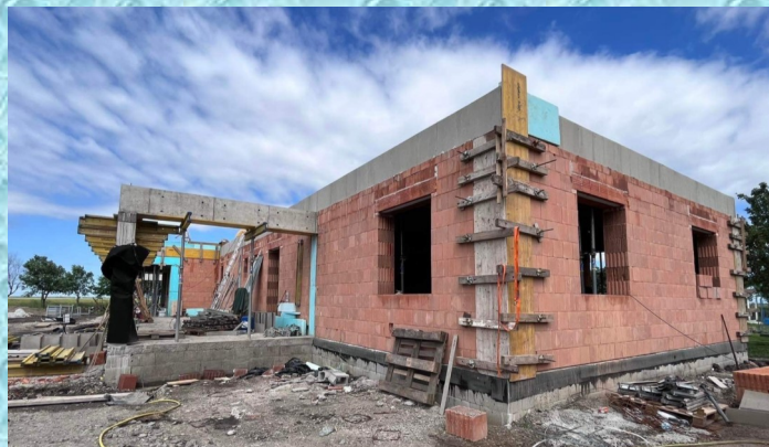
Az új Apavári védelmi központ építése
