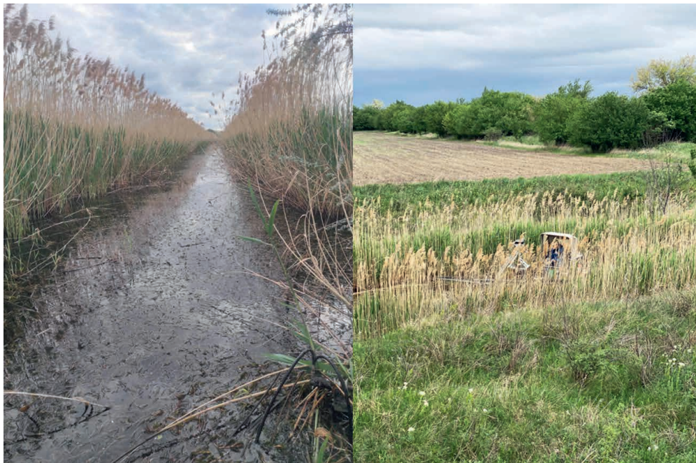
26. kép Mezőtúri VI-a csatorna fenntartása
