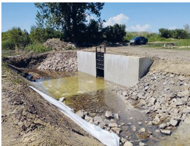
47. kép Helyreállított Doba-28. csatorna összekötő műtárgy
