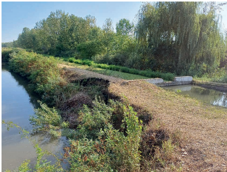
21. kép Nk.III-2-4 csatorna elhabolt töltésszakasza
