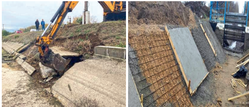
5. kép Tiszafüredi-főcsatorna 20+694 km III. zsilip kimosódás megszüntetése
