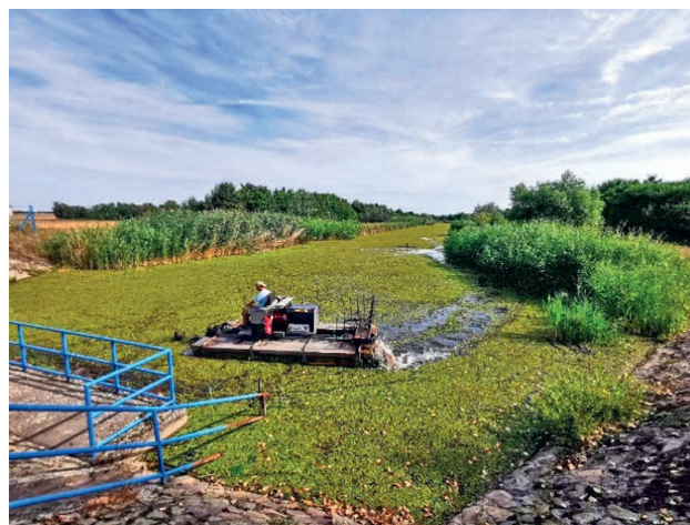
56. kép Nagykunsági-főcsatorna 39. sz. műtárgy előtti truxorozás
