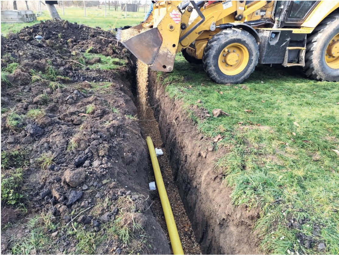
88. kép Drénszivargó kavicságyba helyezése
