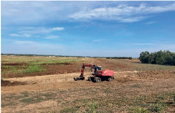
57. kép Gói-tói összekötő áteresz bontás
