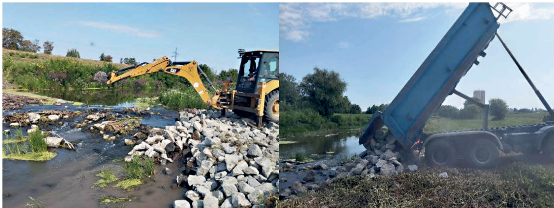
49. kép Zagyvai kőgát helyreállítása
