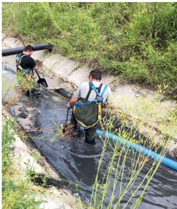
81. kép Görbe-ér mellék csatornából iszap szippantással történő eltávolítása 2024.06.10
