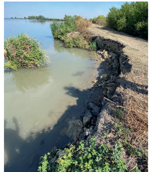
22. kép Kecskeri tározó elhabolás
