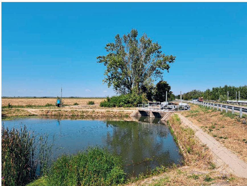
64. kép Nagykunsági főcsatorna 34-es műtárgy
