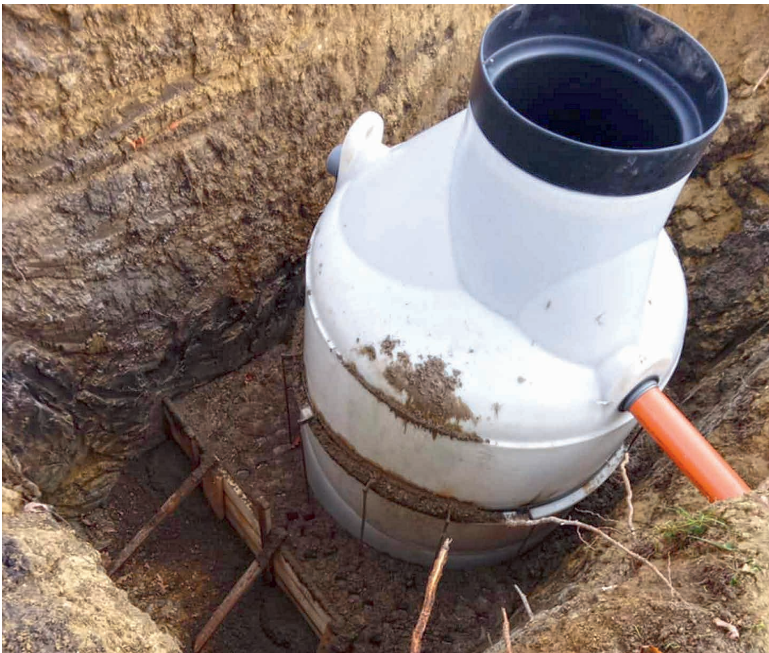
89. kép Az oldómedence betonzása
