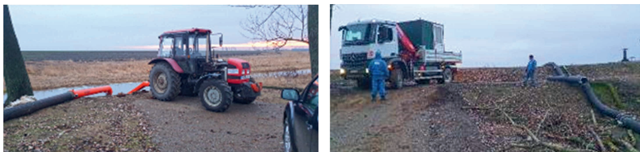
44. kép Csíkos I. csatorna szivattyús felvonulás
