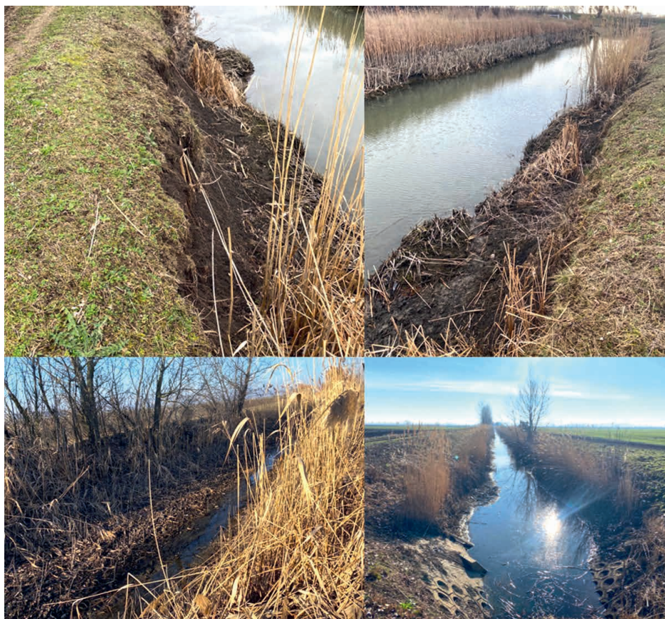
27. kép Megcsúszott szakaszok az NK X-2 öntözőcsatornán
