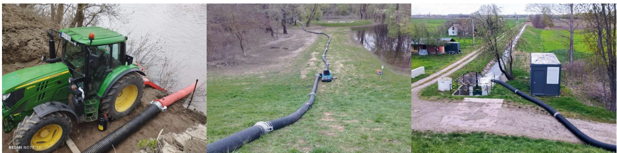
34. kép Tizsakécskei öntözőcsatorna provizóriumos feltöltése
