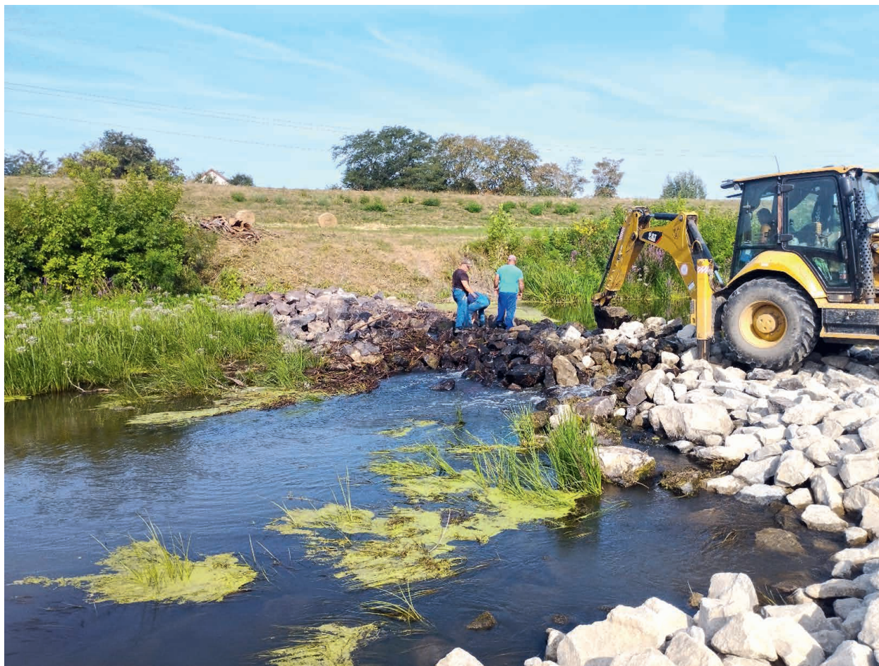
39. kép Kőgát visszapótlása a Zagyva folyó 2,41-2,42 fkm szelvényében
