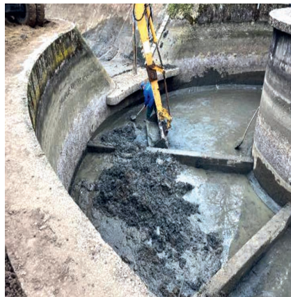
7. kép Csillapító medence kotrása
