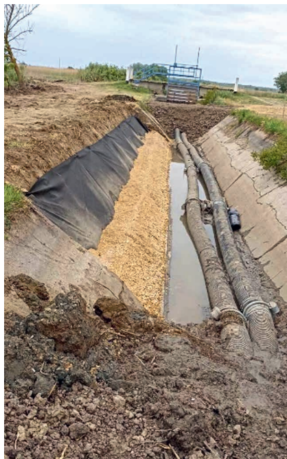
10. kép Helyreállítási munkálatok a Tiszafüredi öntöző-főcsatorna 23+050 km szelvényében 21 fm hosszon
