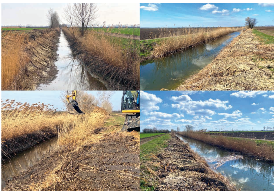
28. kép Csatorna meder helyreállítása az NK X-2 öntözőcsatornán
