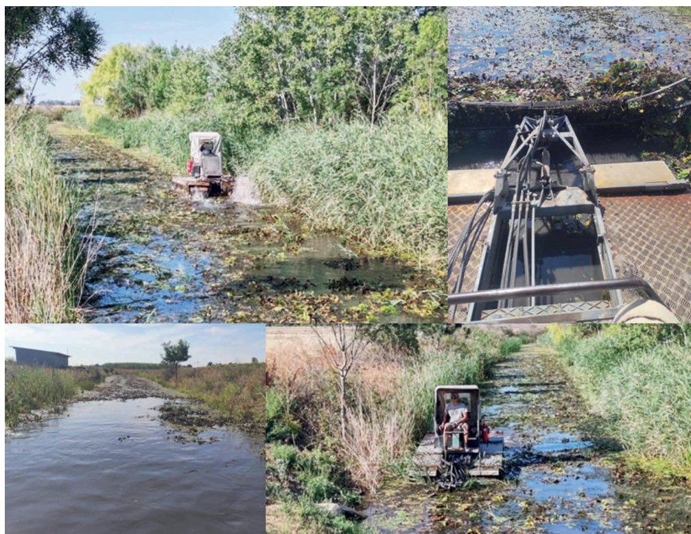
32. kép Harangzugi I. csatorna mederkaszálás truxorral
