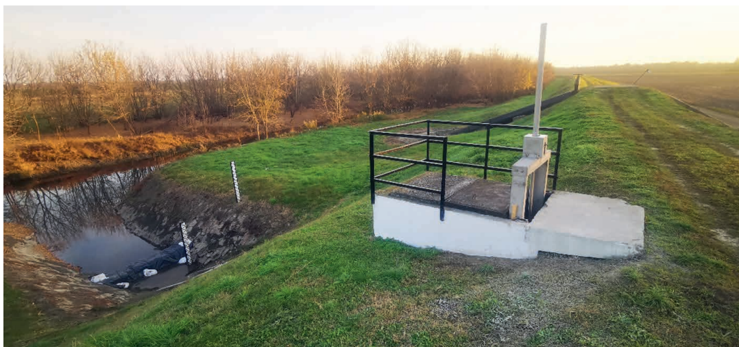
42. kép Rekettyés zsilip új elzárószerkezete
