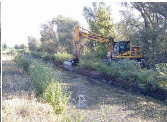
52. kép J. III-1. vízfolyási akadály eltávolítása
