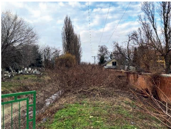
6. kép E-on által levágott faágak a Tiszafüredi öntöző-főcsatorna töltésén
