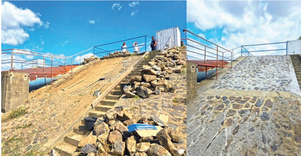
33. kép Nkfc. 39. sz. műtárgy alvízi burkolat helyreállítása
