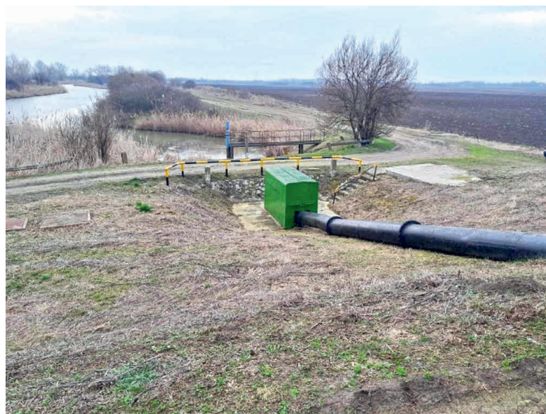
70. kép Szászberki Holt-Zagyva szivornyás vízpótlása az apadó zagyvai árhullámból
