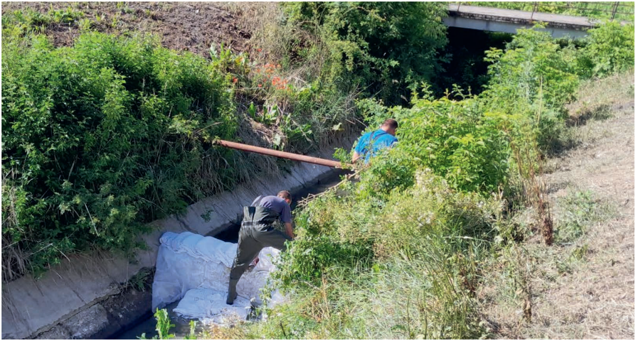
95. kép Szolnok, Görbe-éri mellécsatorna mederelzárás
