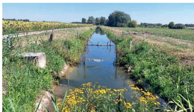
48. kép Tizsakécskei-öntözőcsatorna 7+350 km szelvénye (munkavégzés előtt-közben-után)
