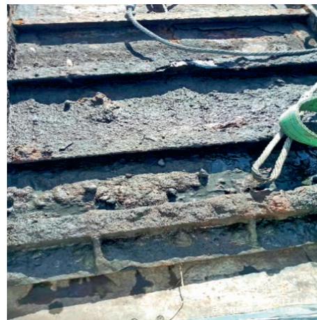
60. kép Sebeséri IV. csatorna műtárgy
