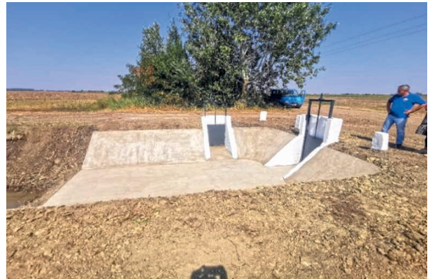
58. kép Kungyalui I-4 műtárgy javítás
