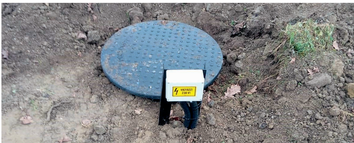
91. kép Az oldómedence visszatöltött állapotban
