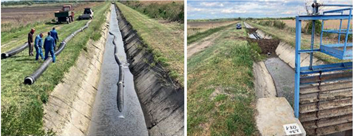
9. kép Helyreállítási munkálatok előkészülete a Tiszafüredi öntöző-főcsatornán
