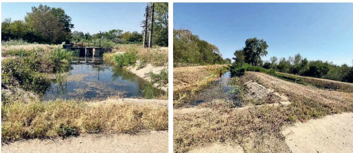
38. kép Elbontott szivattyú akna, gravitációssá váló szakasz
