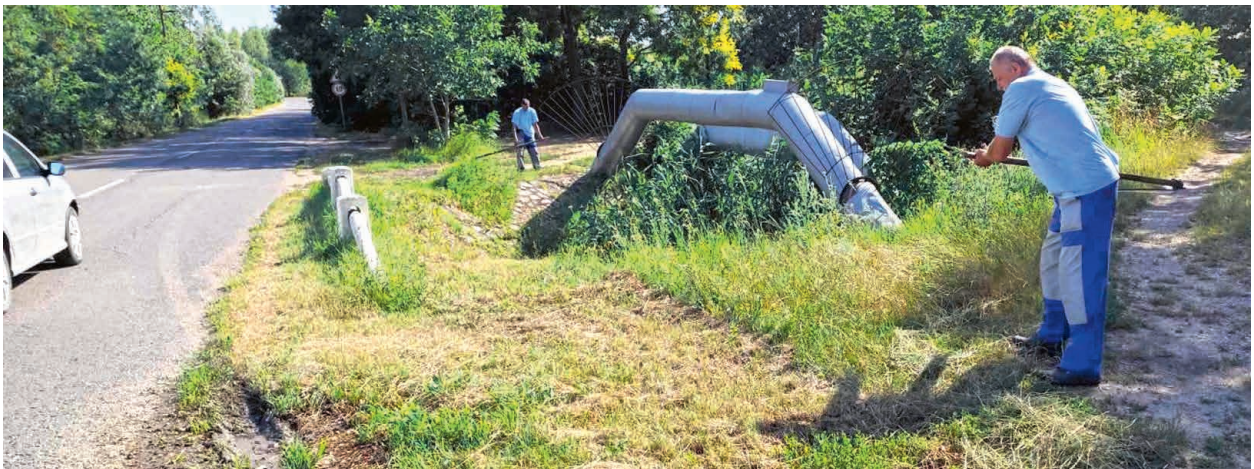
96. kép Szajoli I. csatorna műtárgy karbantartás
