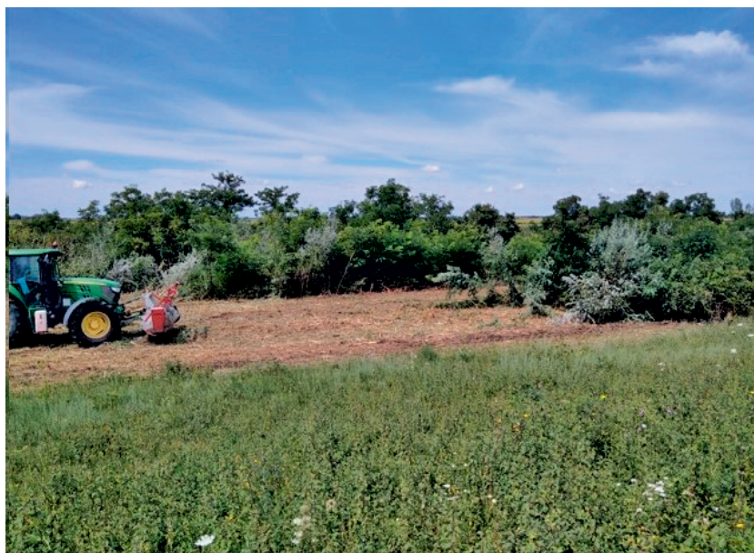
32. kép Nagykunsági-főcsatorna Keleti-ág mentett oldali rézsú gaztalanítás
