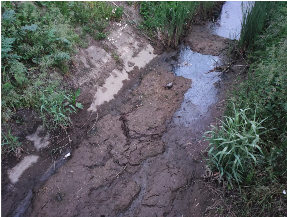
86. kép Csatorna kotrás előtt
