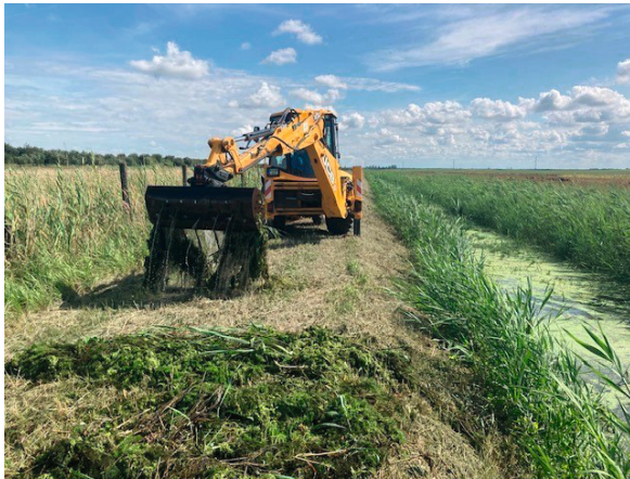
14. kép az Örvényabádi 2. csatorna karbantartása, kaszálás a depónián
