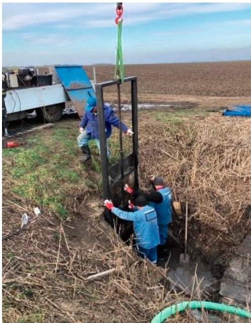
34. kép Tiszavárkonyi I. öntözőcsatorna vízszint szabályozó zsilip
