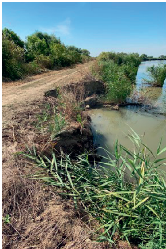
22. kép Kecskeri-tározó töltés elhabolódása
