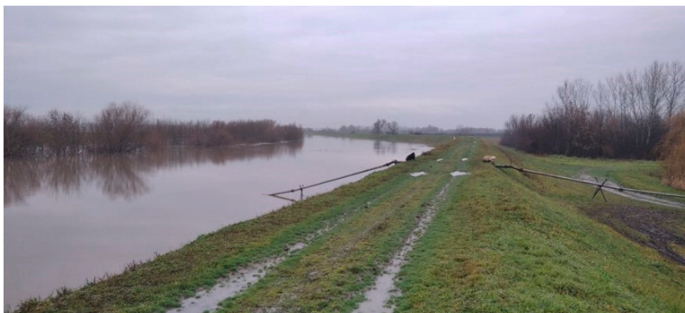
67. kép Alattyáni horgásztó szivornyas feltöltése
