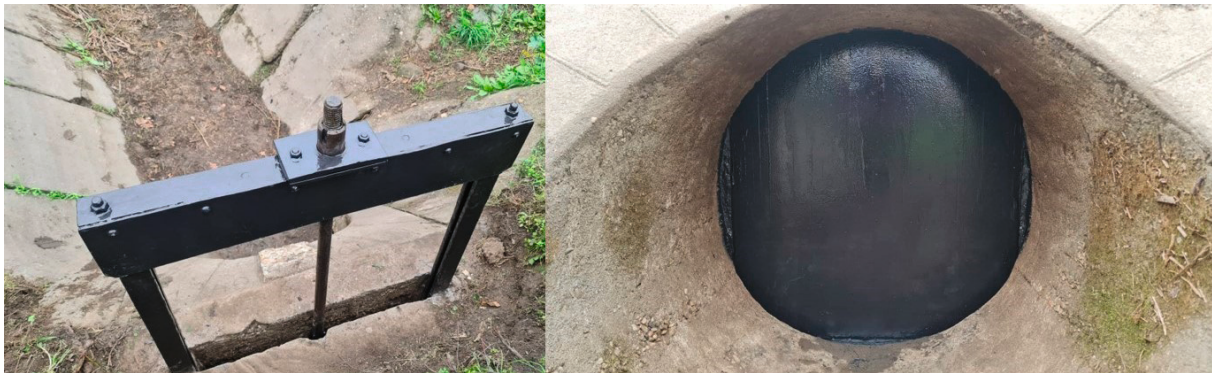
27. kép Mezőtúri VI. csatorna 14+090 szelvényében lévő tiltós elzárás vízvisszatartó műtárgy javítása
