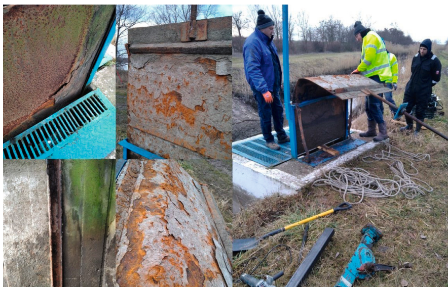
25. kép Tiltós műtárgy javítása
