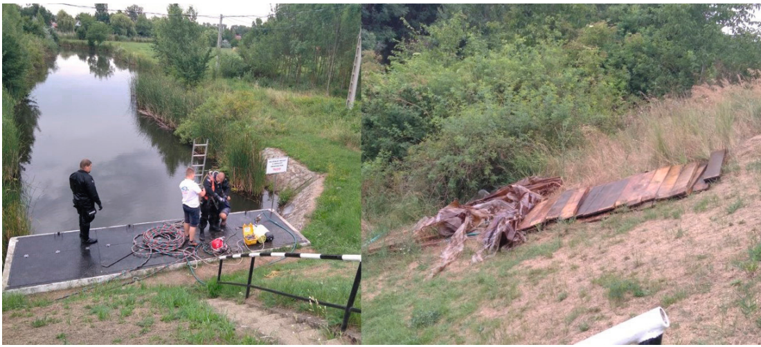
30. kép Harangzugi I. csatorna 0+150 szelvény négy nyílásos tiltós műtárgy tisztítása
