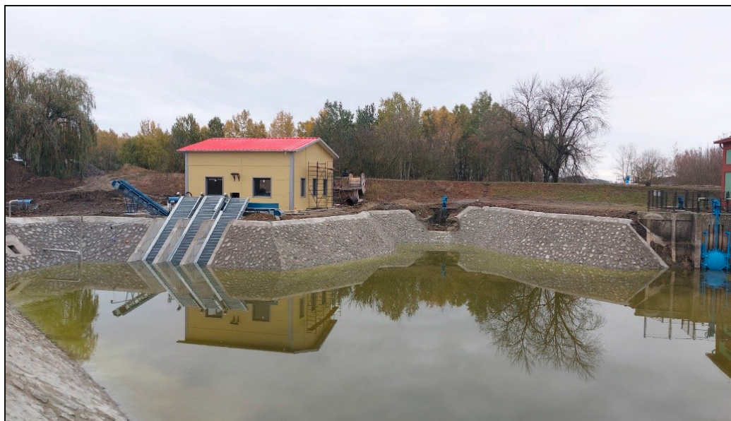
46. kép Gástyás II. szivattyútelep átépítése
