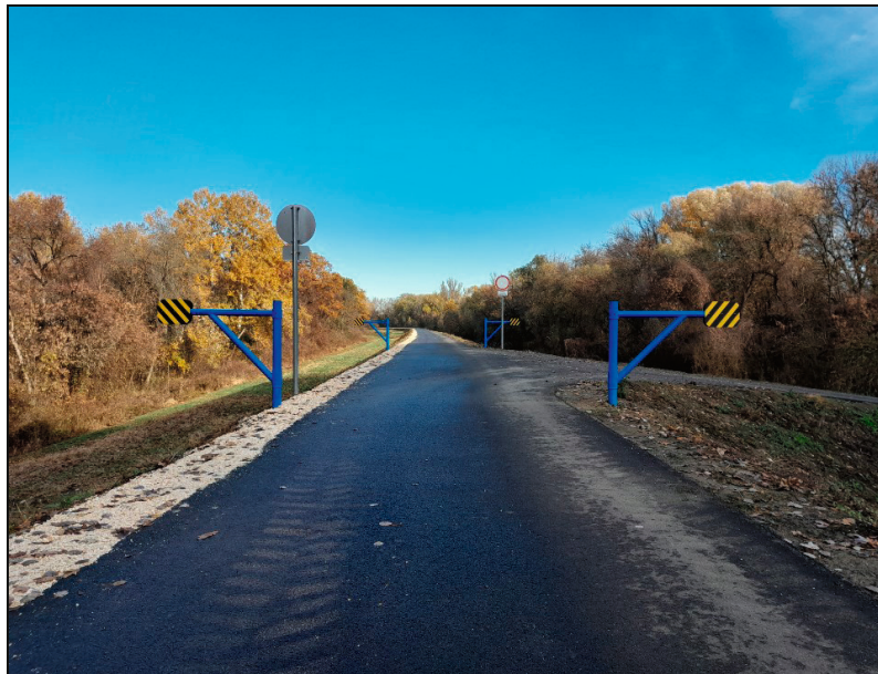
51. kép Burkolt árvízvédelmi töltés
