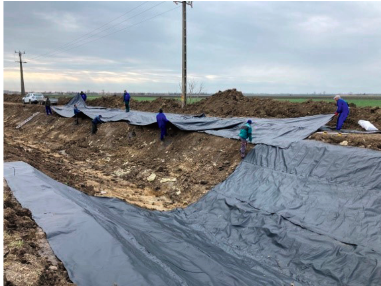
33. kép Tiszavárkonyi I. öntözőcsatorna fóliázás
