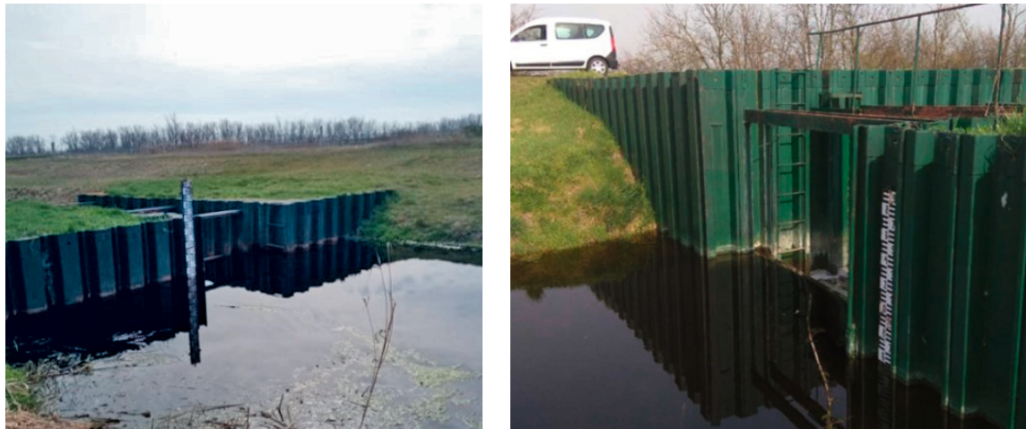
71. kép Gerje-Perje belvízrendszer elzárótáblák behelyezése, Gerje csatorna, Közös csatorna 7+600km
