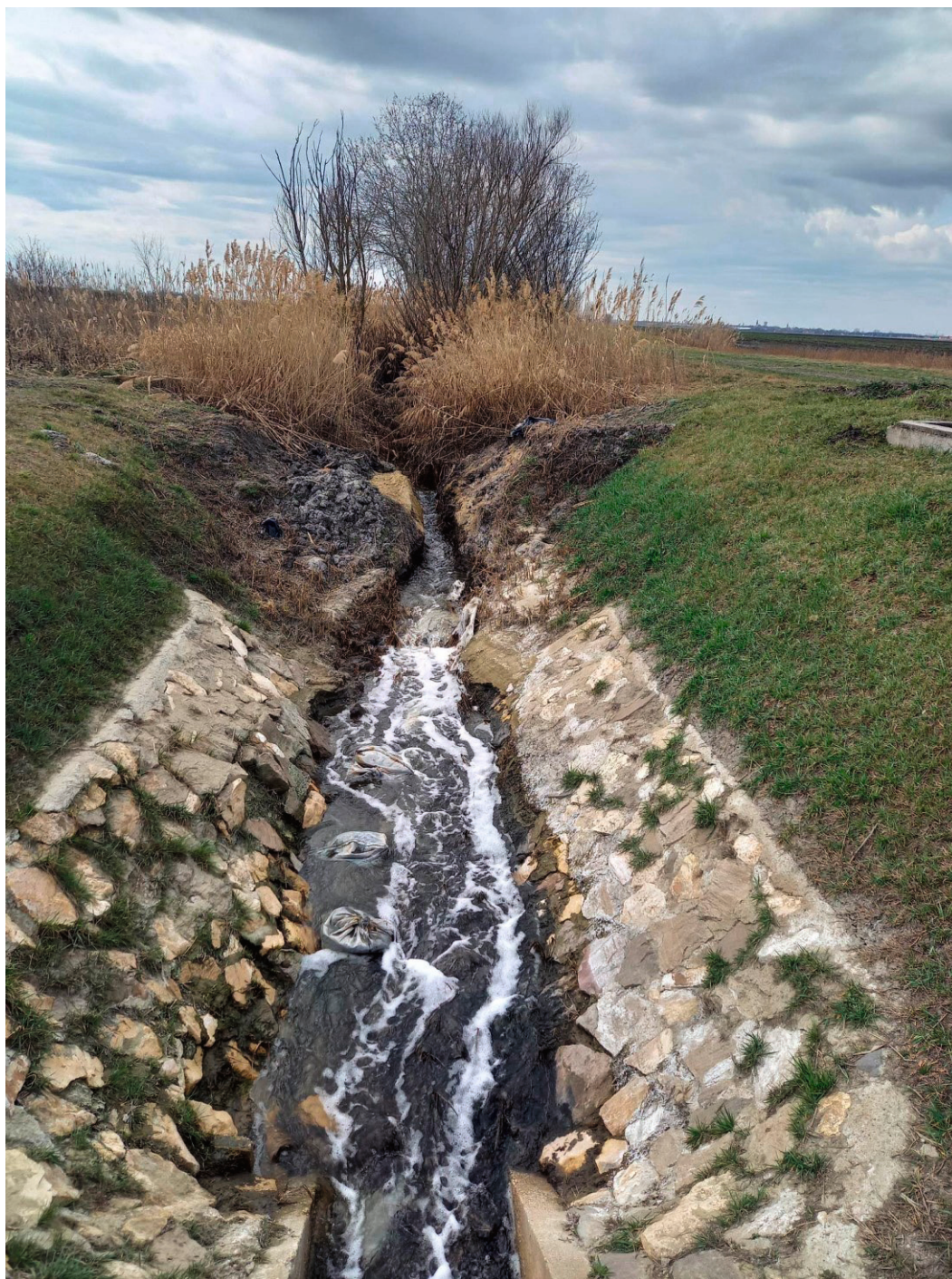
79. kép A korábban kiépített ideiglenes elzárás elbontása
