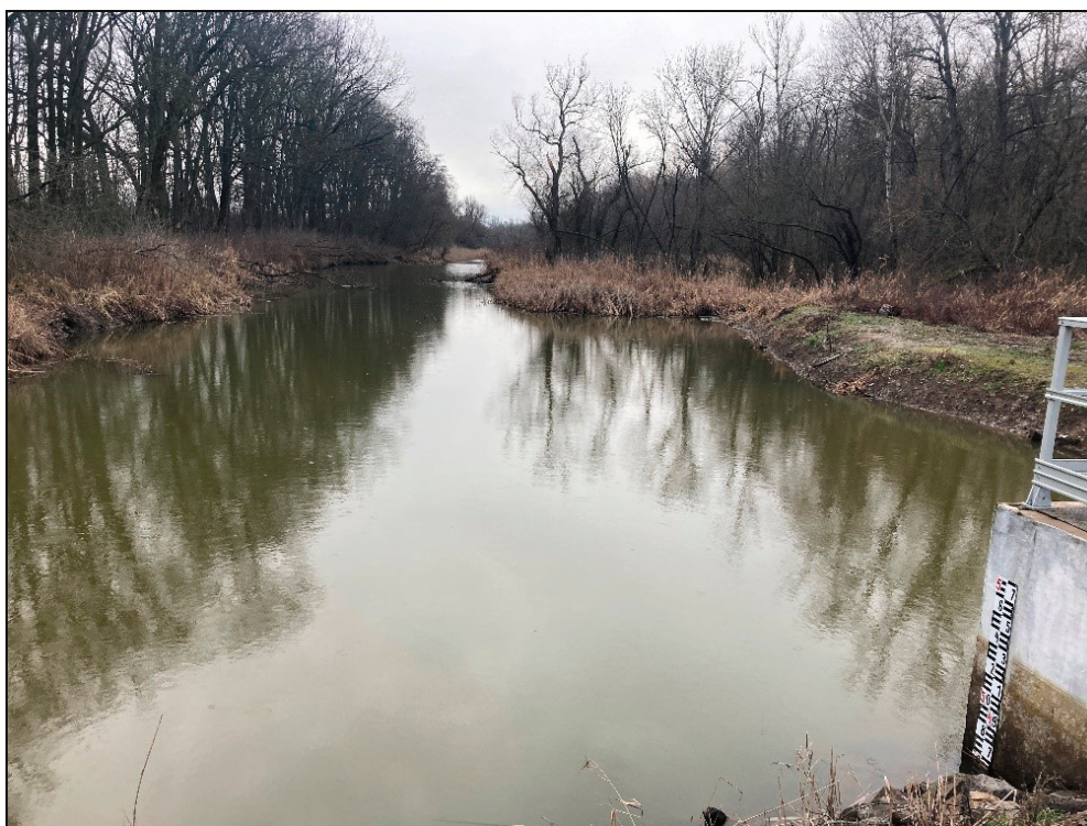
53. kép Cserőközi Holt-Tisza vízvisszatartás
