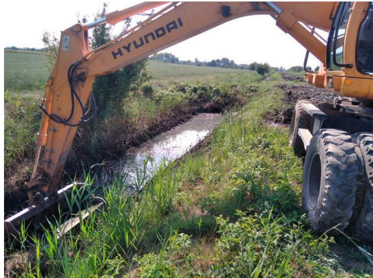
36. kép 18. számú belvízcsatorna kotrási munkálatok
