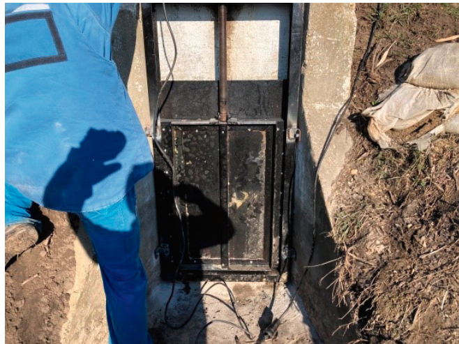
34. kép Tiszavárkonyi I. öntözőcsatorna vízszint szabályozó zsilip
