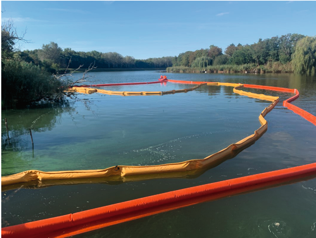
81. kép Alcsi-Holt-Tiszán feltételezett szénhidrogén szennyezés lehatárolása merülőfalak használatával
