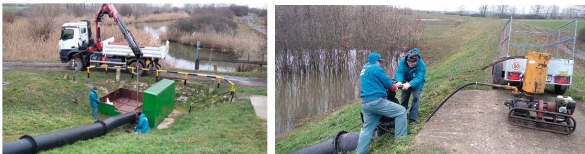
54. kép Szászberki Holt-Zagyva szivornyás vízpótlása az apadó zagyvai árhullámból
