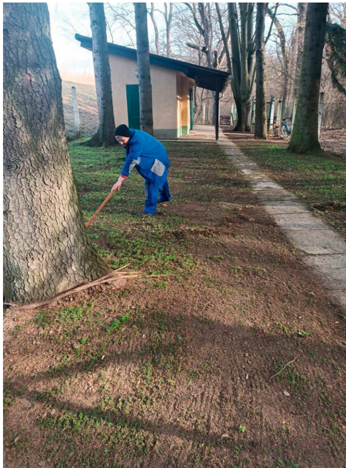
89. kép Tizsakürti szivattyútelep fenntartás
