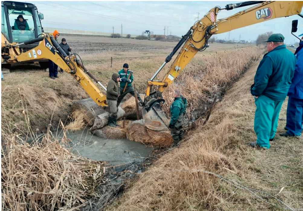
88. kép Mederelzárás a Gerjén, Ceglédnél
