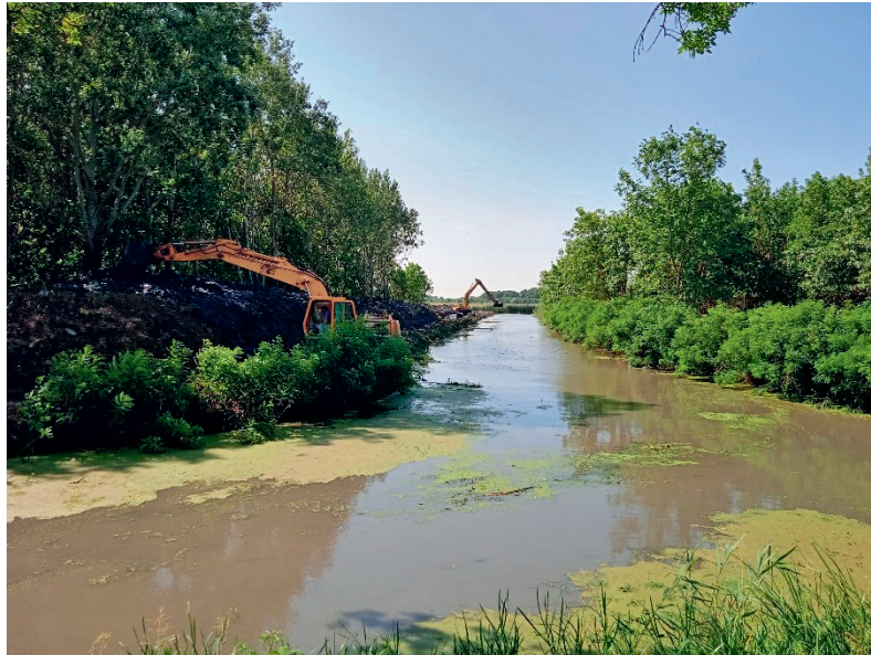
21. kép Gástyási öböl és a rávezető csatorna iszaptalanítása, kotrása
