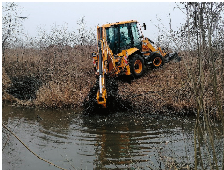
52. kép Vízfolyási akadály eltávolítása 10.04 védelmi szakasz
