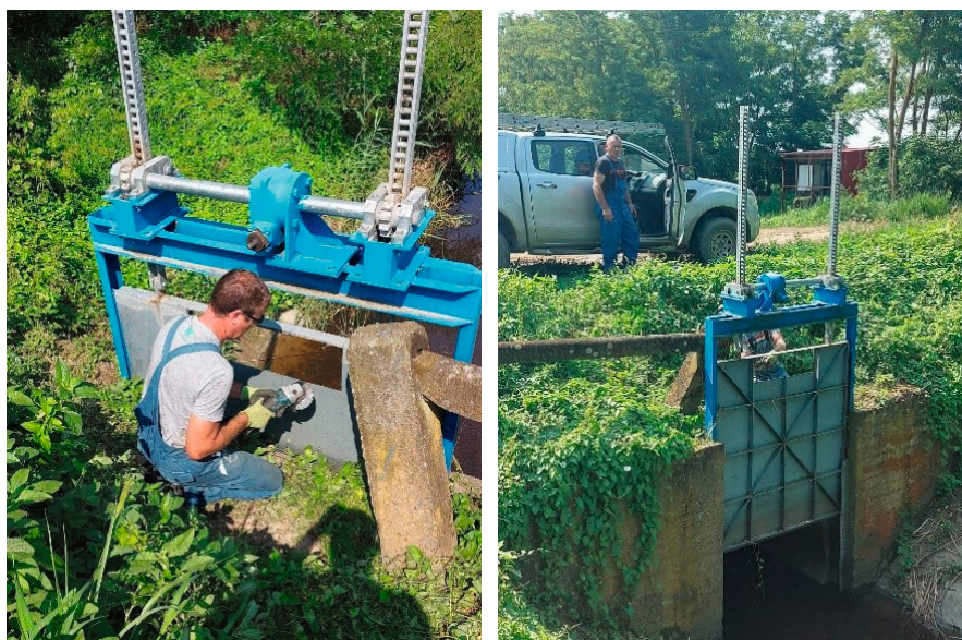
16. kép Nagyfoki I-18. csatorna beeresztő műtárgy zsilip átalakítása
