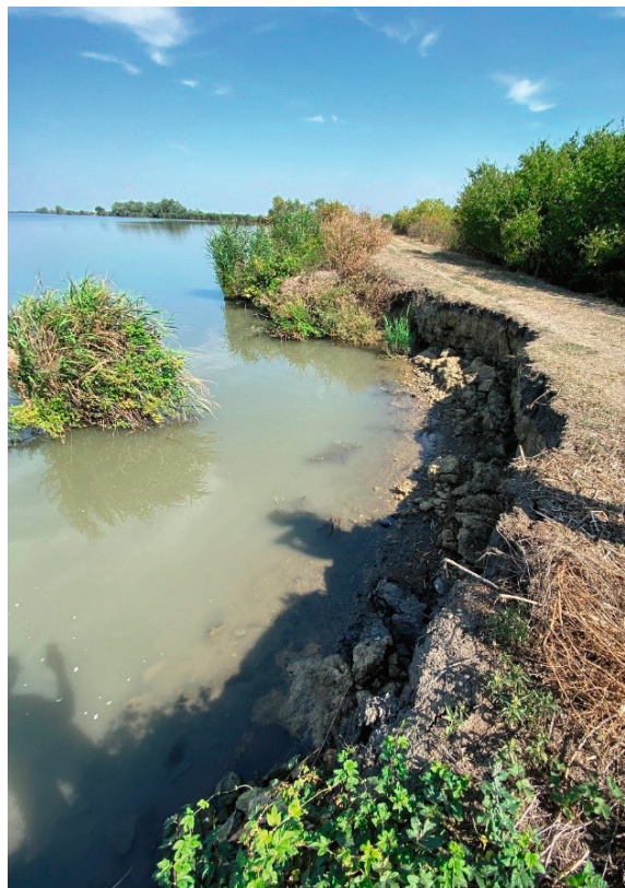
22. kép Kecskeri-tározó töltés elhabolódása
