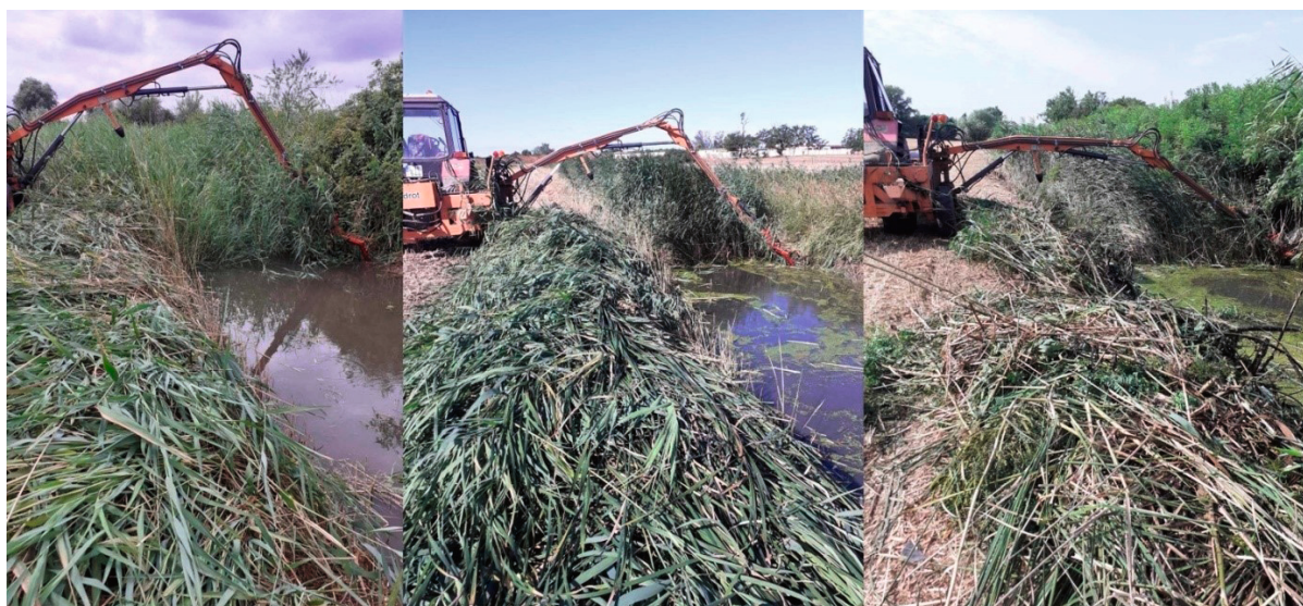
29. kép Kiskengyeli csatorna mederkaszálás
