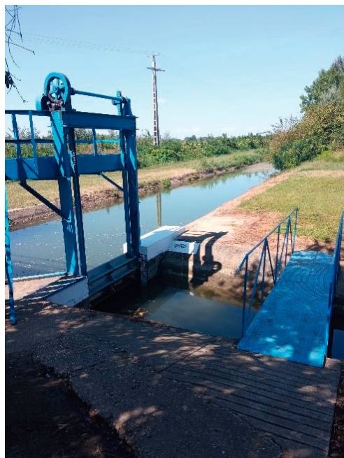
8. kép Tiszafüredi II. mellékcsatorna bereresztő műtárgy
