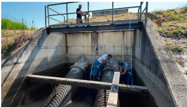
6. kép Tolózár átalakítása, speciálisan kivágott lemez beépítése
