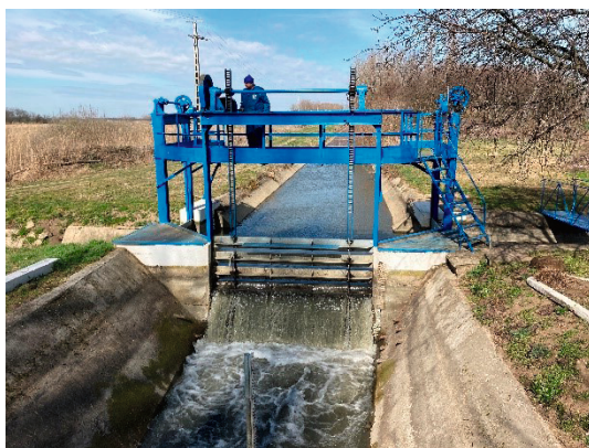
7. kép Tiszafüredi-öntözőrendszer átöblítése, uszadék eltávolítása
