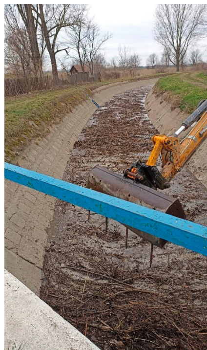
7. kép Tiszafüredi-öntözőrendszer átöblítése, uszadék eltávolítása
