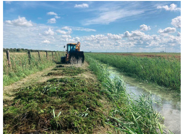
14. kép az Örvényabádi 2. csatorna karbantartása, kaszálás a depónián
