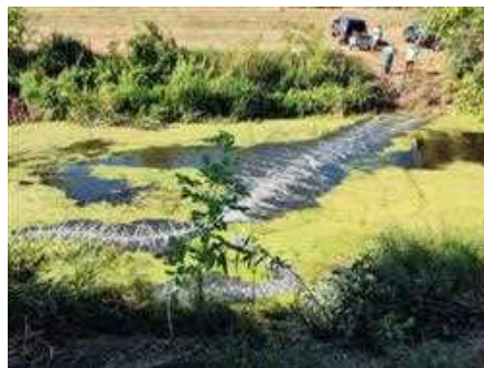
35. kép Zagyva folyó levegőztetése a szennyvíztisztító telep bevezetése alatt
