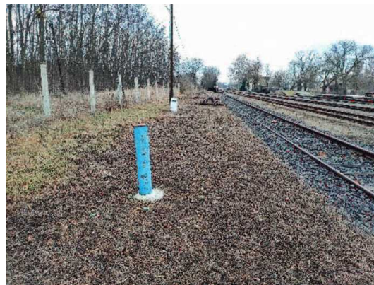
15. kép MOL Nyrt., Kunhegyes 2902, 2903/2, 2580/1 hrsz. alatti 17 db kármentesítési monitoring kút eltömedékelése.
