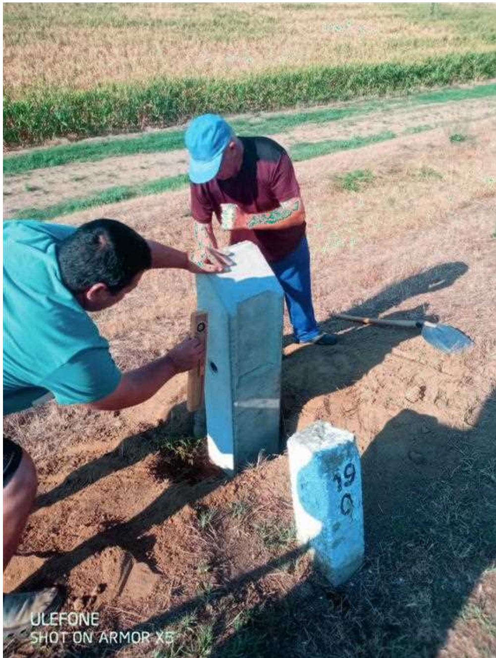
53. kép Vezseny, töltéstartozékok elhelyezése
