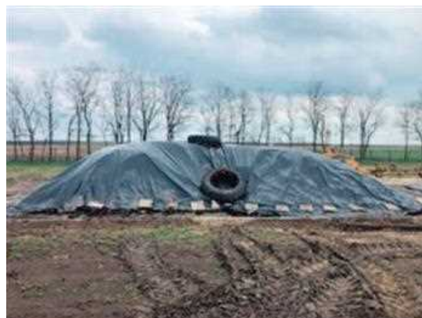
45. kép A kitermelt szennyezett talaj fóliás takarással ellátva
