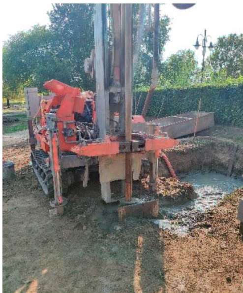
20.kép Martfű Város Önkormányzata, Martfű 349/59 hrsz. alatt tervezett 75 m-es locsolókútjának fúrása
