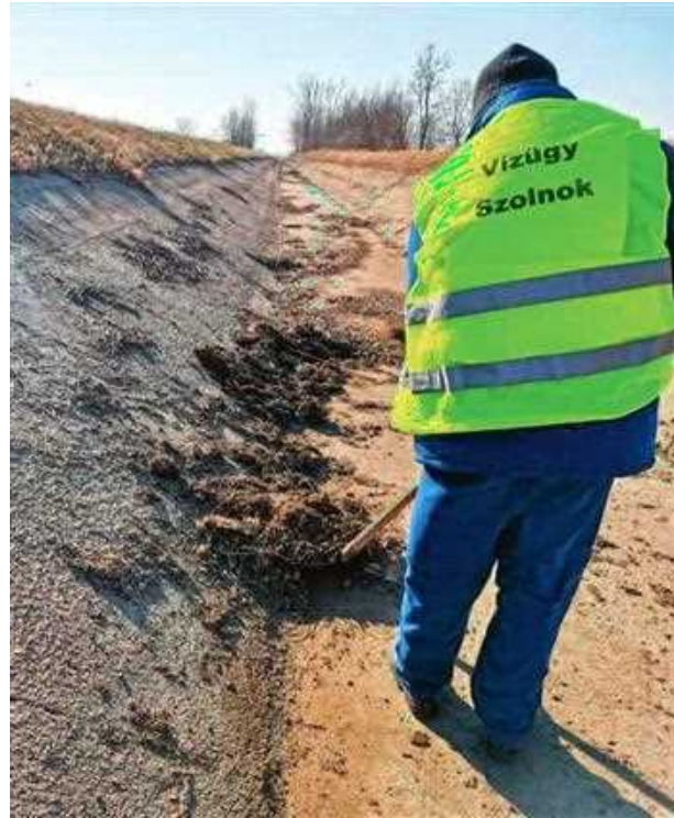
51. kép Tiszafüredi IV. mellécsatorna iszaptalanítás
