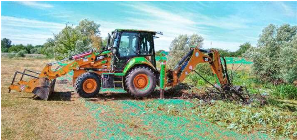
22. kép Lefolyási akadály eltávolítása
