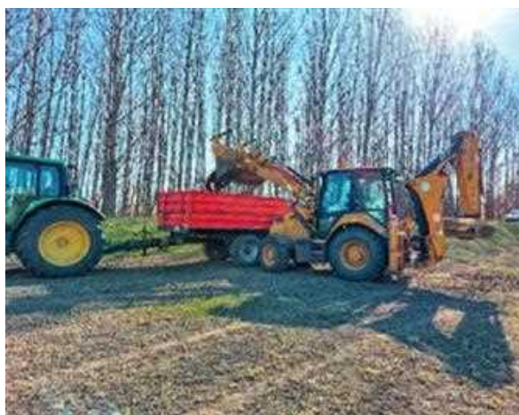
27. kép Zagyva folyó 0+950 fkm szelvény, gumibroncsok rakodása elszállításához
