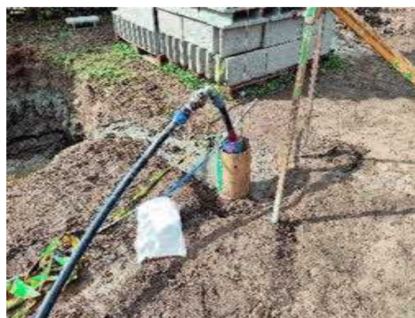
20.kép Martfű Város Önkormányzata, Martfű 349/59 hrsz. alatt tervezett 75 m-es locsolókútjának fúrása
