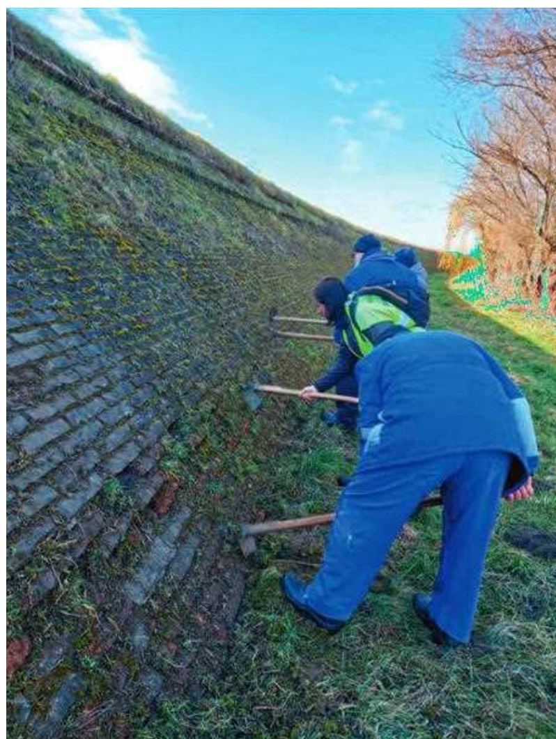
50. kép Tizzasüly, téglafalazat karbantartása
