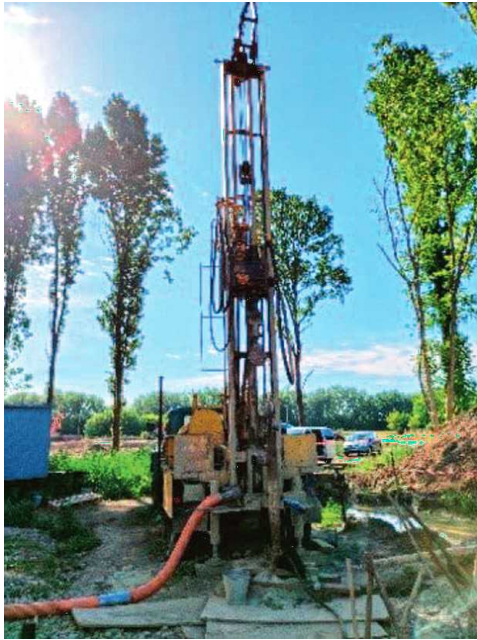
17. kép Green Plan Center Kft., Szolnok 16435/17 hrsz. alatt tervezett 660 m-es termálkút és 180 m-es hidegvizes kút fúrása.
