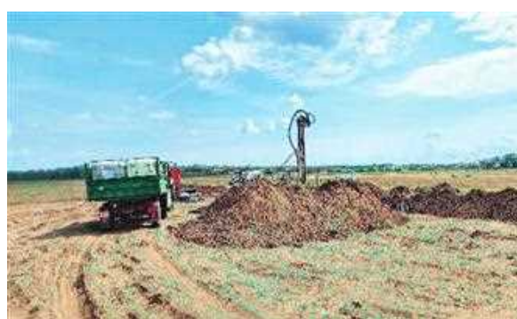
16. kép Fiala Károly, Jászberény, külterület 0623/14 hrsz. alatt tervezett 50 m-es öntözőkútjának fúrása.
