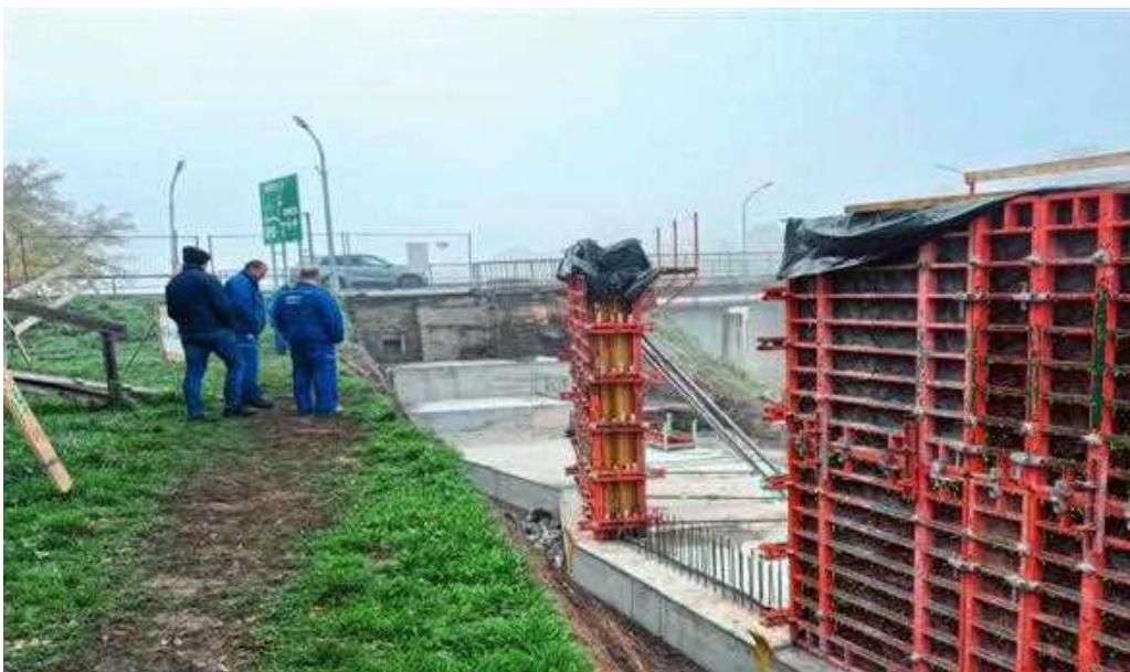
24. kép A "Bástya támfal és sétány" építésének ellenőrzése Szolnok belterületén
