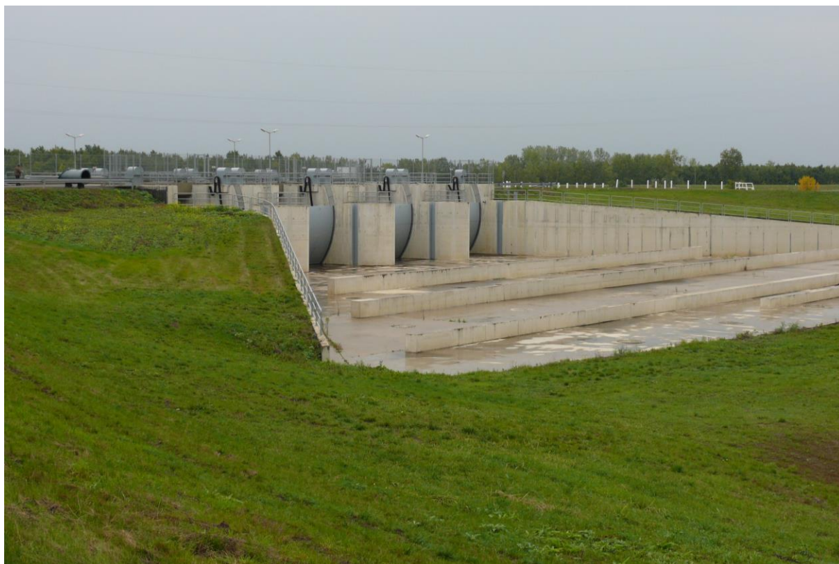
Hanyi-tizsasülyi árvízszint-csökkentő tározó beeresztő műtárgya
