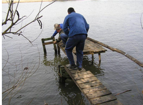
Illegális vízi létesítmény elbontása áprilisban
