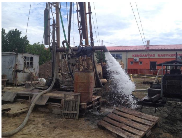
A kút kompresszorozás közben 1500 l/perc vízhozamot ad
