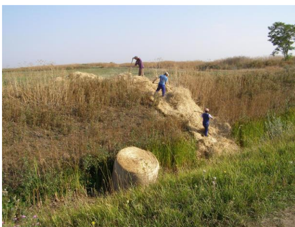
Vízfolyási akadály eltávolítása a Karcagi I. főcsatornán augusztusban
