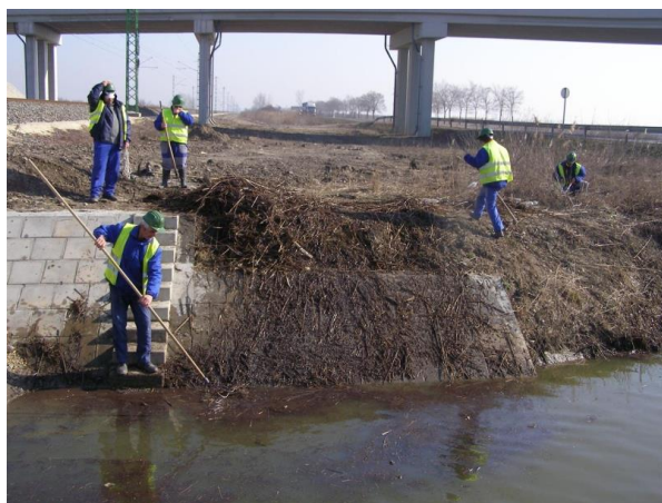
Katré eltávolítása a Karcagi II. főcsatornából márciusban
