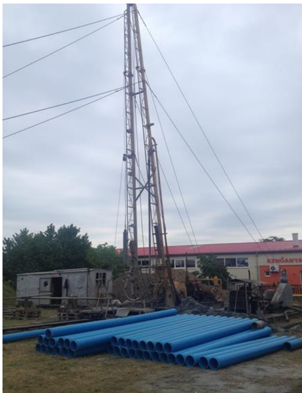
A kútfúró berendezés előtérben a PVC béléscsővel és szűrőcsővel
