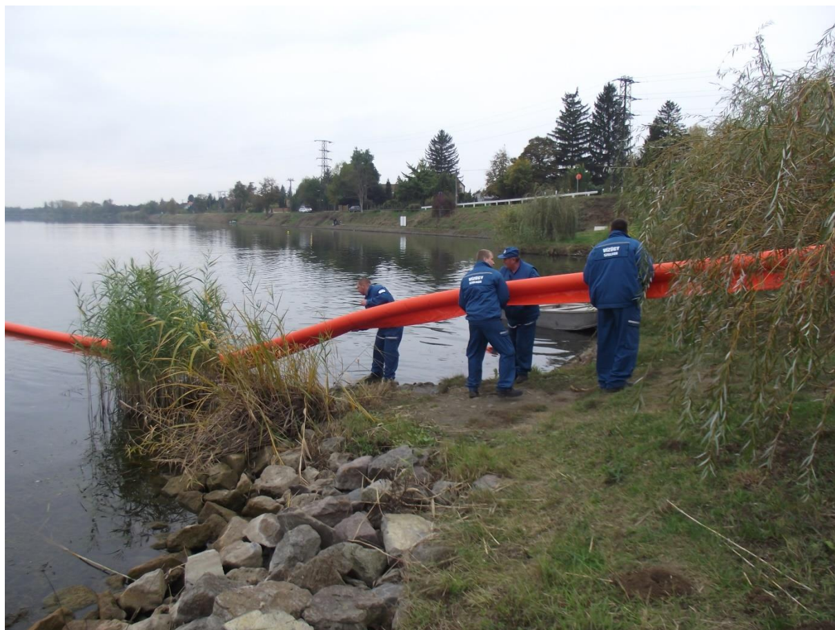
Merülőfal telepítése a szennyezés lokalizására
