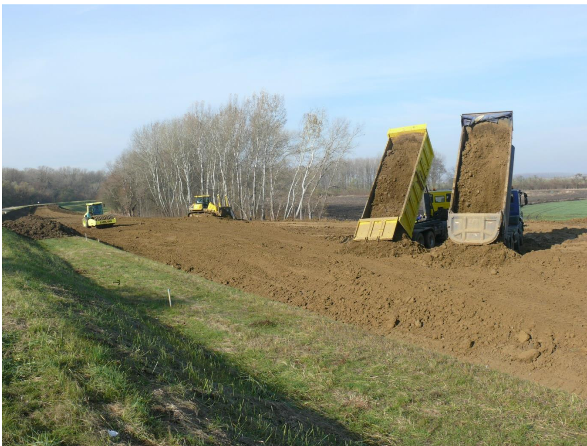
Új földmű építése a töltésáthelyezéssel érintett Keskenyi szakaszon
