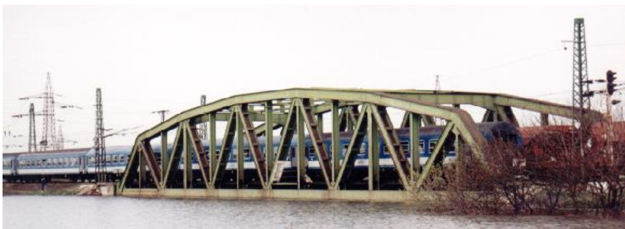
A Zagyván átívelő vasúti híd Szolnokon, amit kövel megrakott szerelvényel terheltek le akkor
