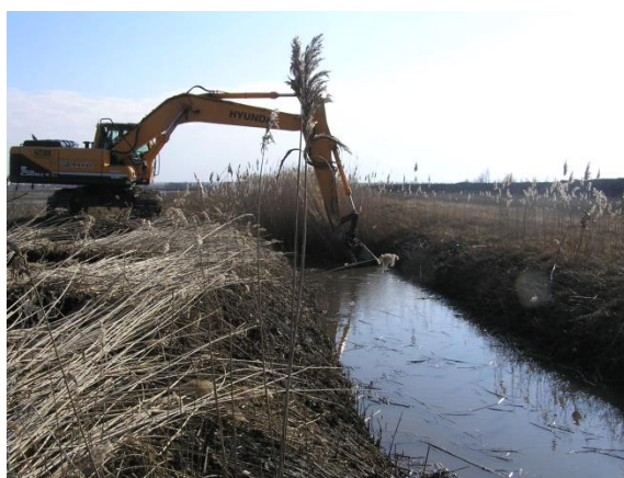
Csatorna kotrása a 10.09-es szakaszon
