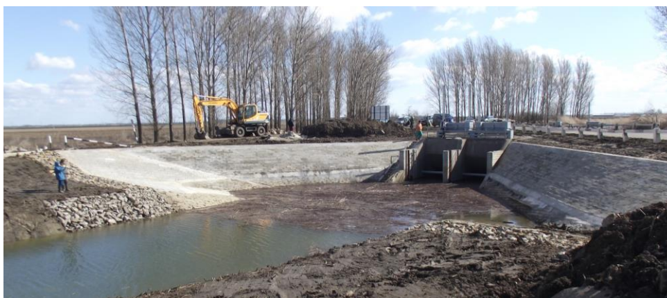
Az Nkfc. felújított 34. számú műtárgya
