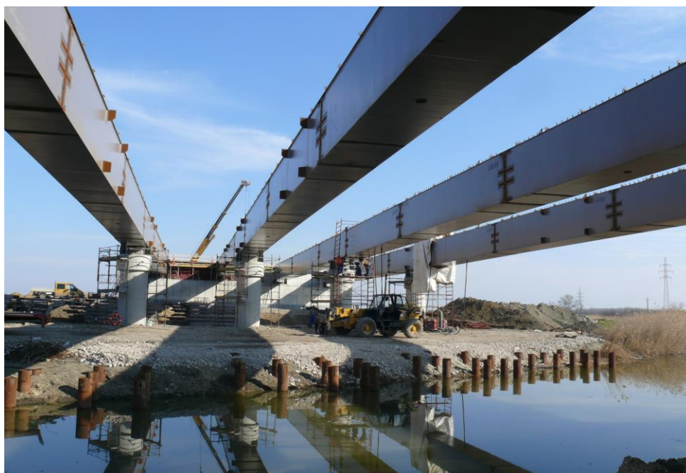
A leállítással nagyon sok építési munka maradt félbe
