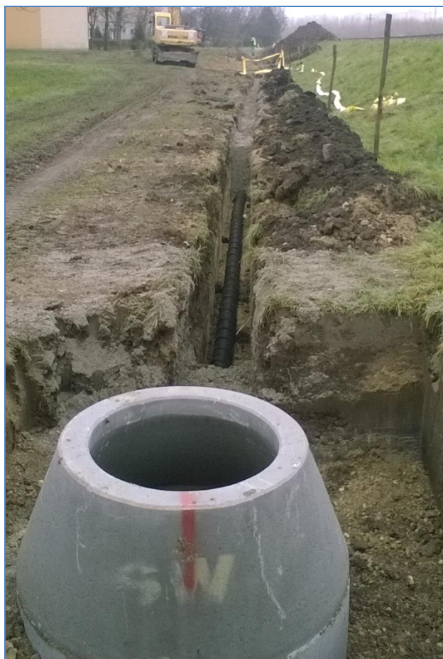
Építés közbeni állapot a Zagyva töltésén
