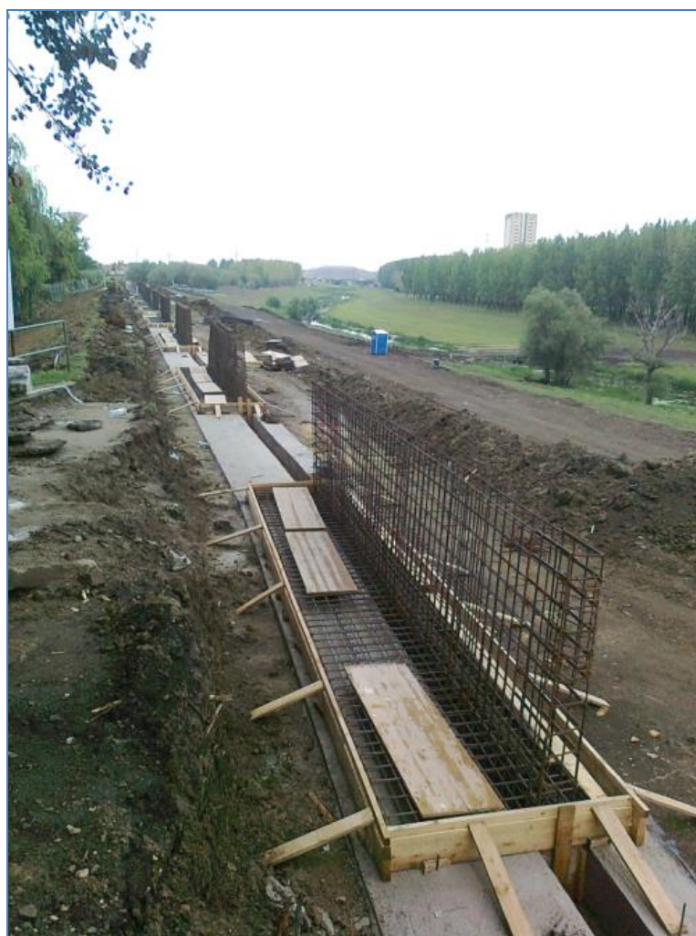
A zagyvai szögtámfal betonozás előtt
