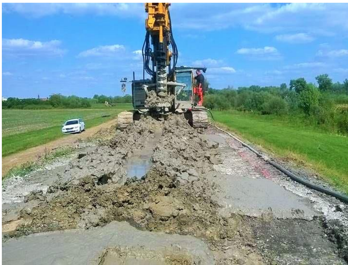
Önszilárduló résfal építése a Zagyva jobb part 14+616 - 17+466 tkm között
