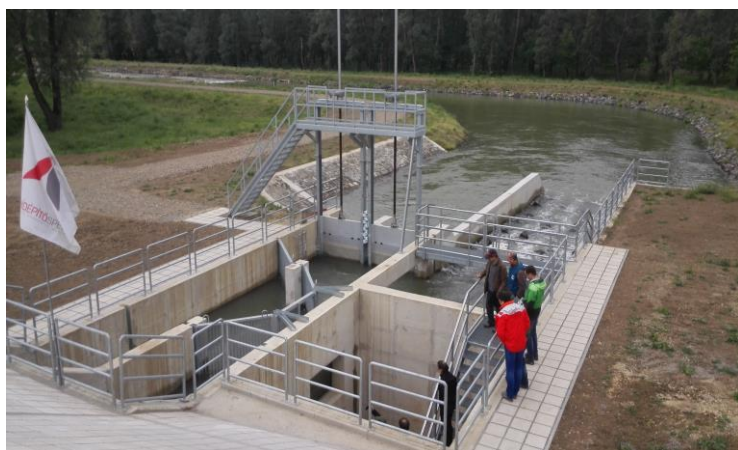
A hallépcső tápláló zsilip a durva rámpával
