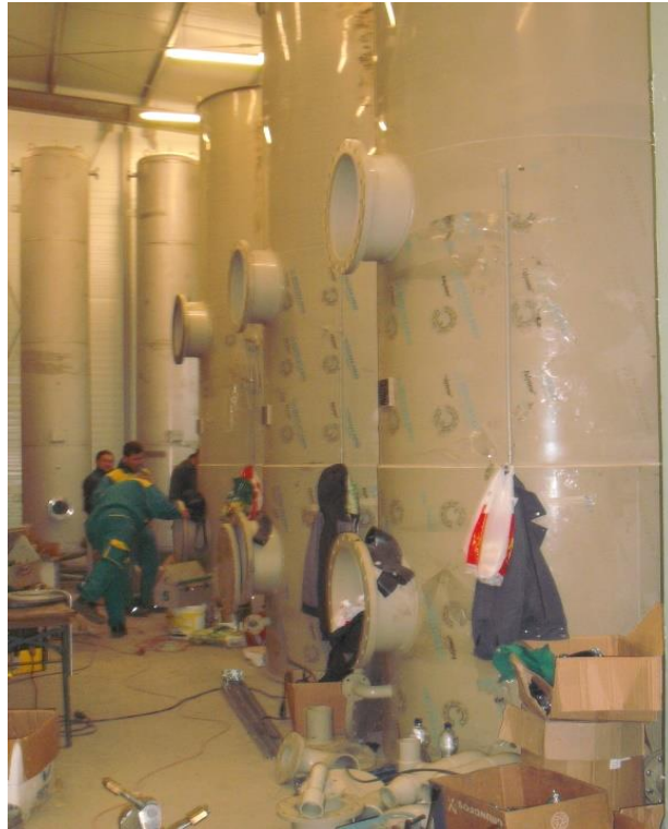
KOI szűrők a beépítés során
