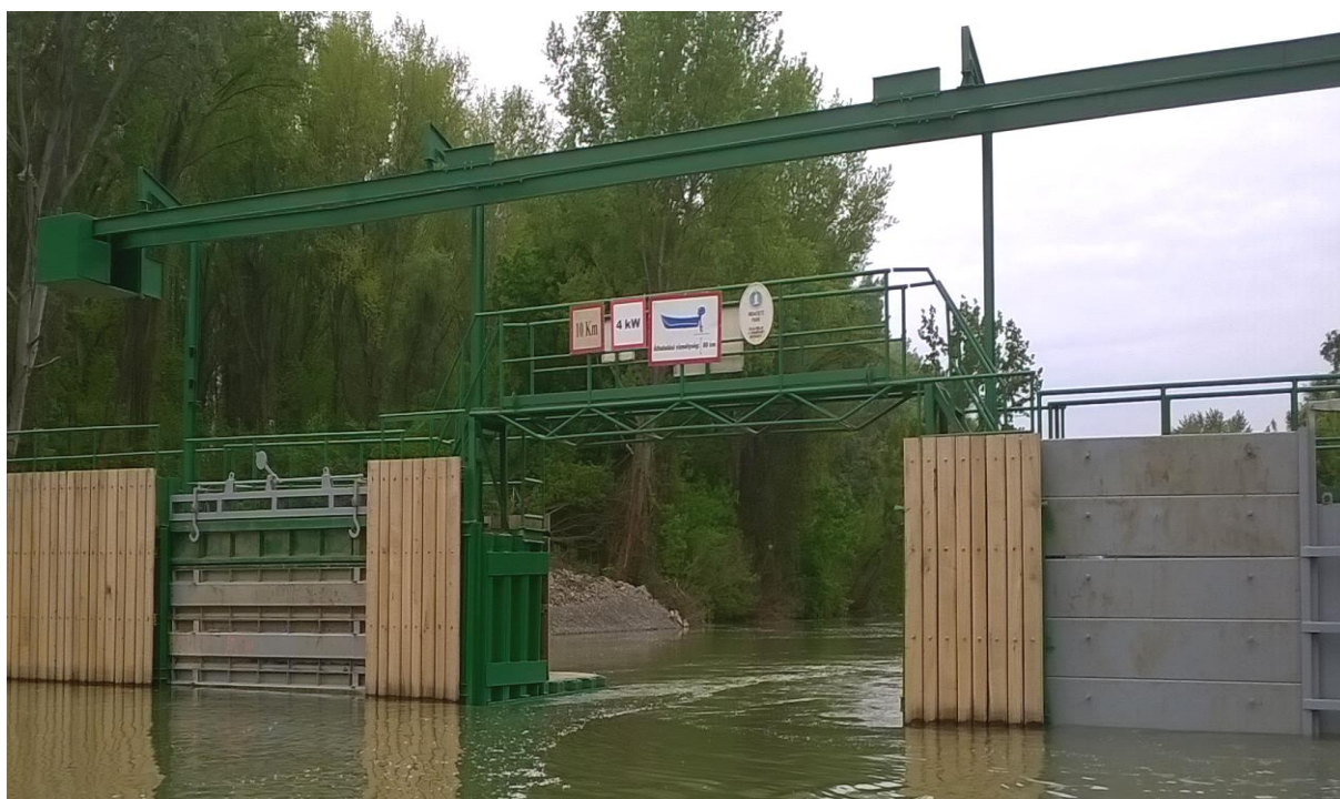
A felújított V. számú öblítő műtárgy
