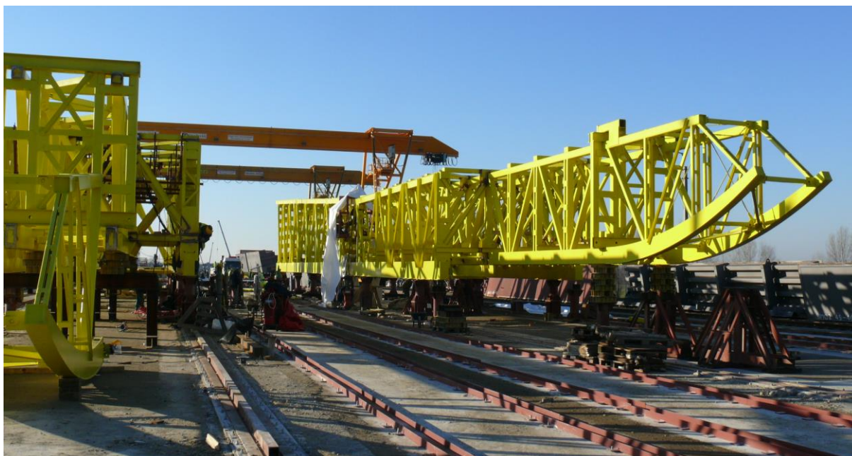
Teherhordó acélszerkezetek összeszerelése
