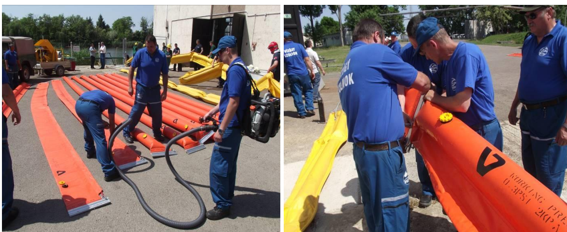
A merülőfalak előkészítése és összeszerelése
