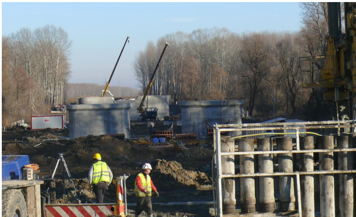
A tiszai hullámtérnél elkészült hídpillérek
