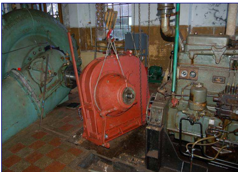
41. fotó. Hajtómű felújítás
