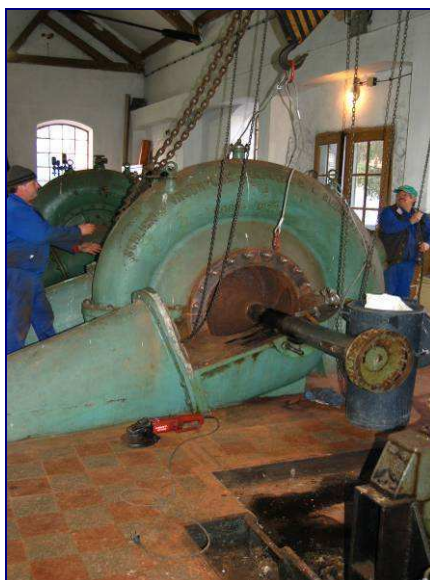
40. fotó. Schlick-Nikolson szivattyú felújítása
