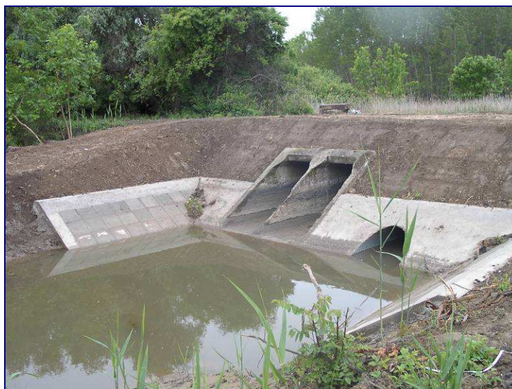
10. fotó. Műtárgybővítés a Kakat-csatorna 32+610 km szelvényében
