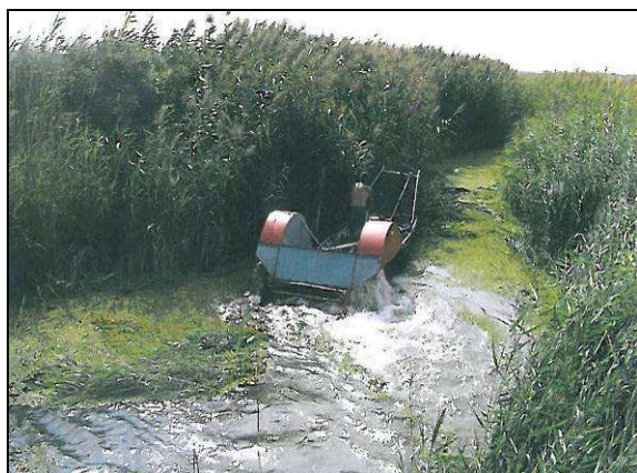
3. fotó. Vízínövényzet vágása a Millér-csatornán
