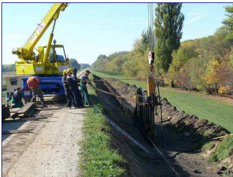
26. fotó. A Fegyvernek térségében megjelent töltéssérülés helyreállítása
