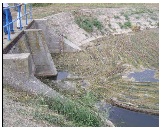
4. fotó. Nkfcs. 31. sz. műtárgynál feltorlódtott vízínövényzet
