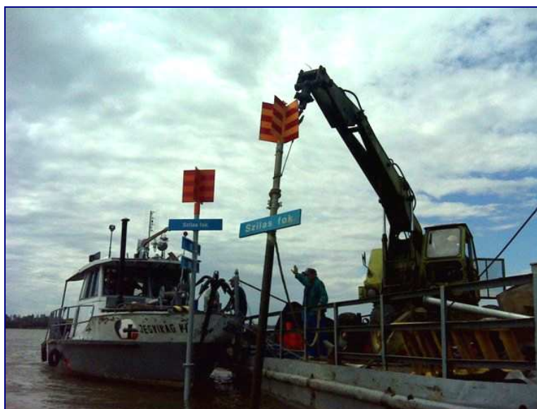
56. fotó. Táblák helyszíni beépítése
