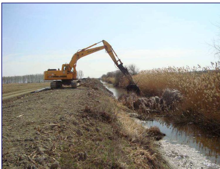
9. fotó. Csátés (22-es) csatorna kotrása
