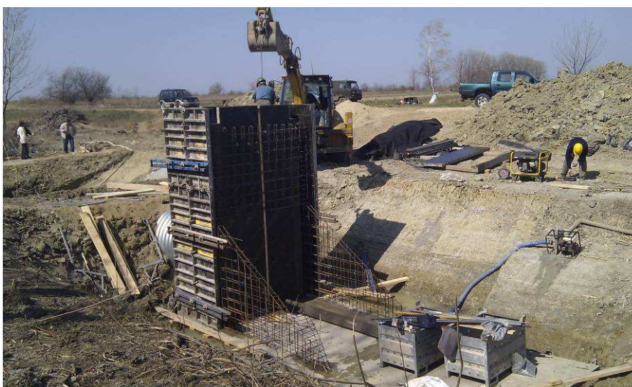
7. fotó. A 3. számú műtárgy építése az 5-120-as csatorna 2+396 km szelvényében
