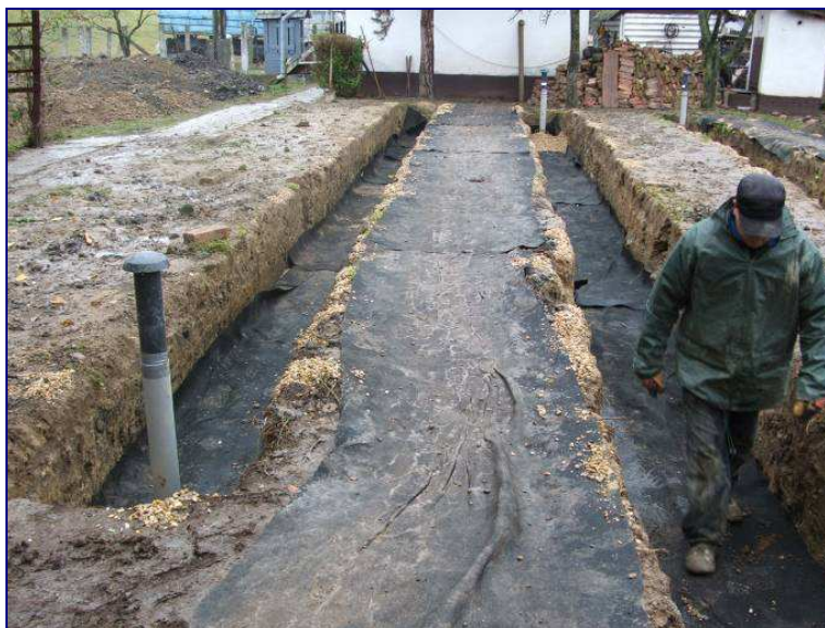
12. fotó. Geotextiliával fedett szűrőréteg
