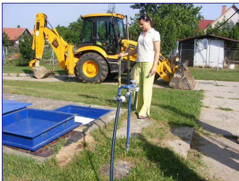
71. fotó. Ceglédbercel vízmű vízügyi szemléje
