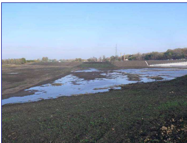
25. fotó. A Jászsági-főcsatorna bújatója fölött megjelent vizesedés (2012. 10. 31.)
