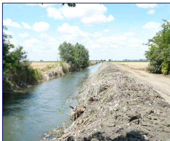
35. fotó. Vízpótló útvonal cserjeirtása, kotrása
