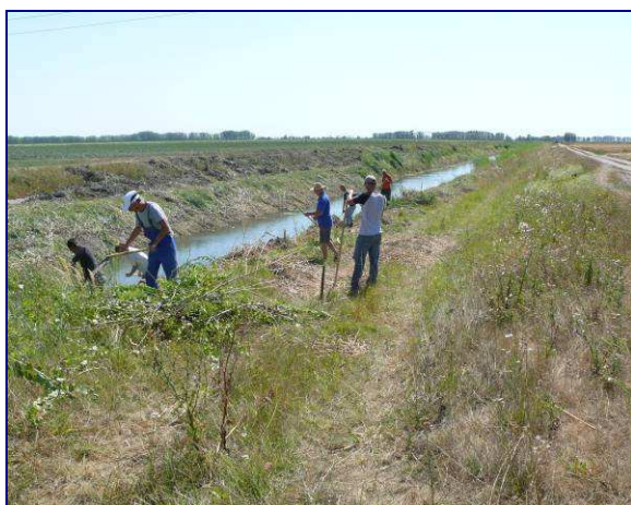
35. fotó. Vízpótló útvonal cserjeirtása, kotrása
