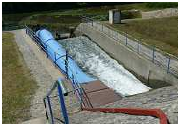
5-7. ábra: Nkfcs. Nyugati-ág 39. jelű műtárgynál beépített vízturbina
