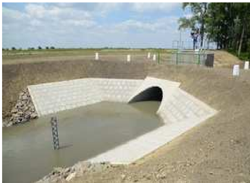
5-25. ábra: Új műtárgy a Doba belvízfőcsatorna 4+128 km szelvényben
