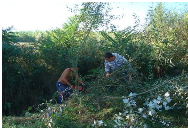
16-3. ábra: Cserjeirtás csatorna depónián és medrében
