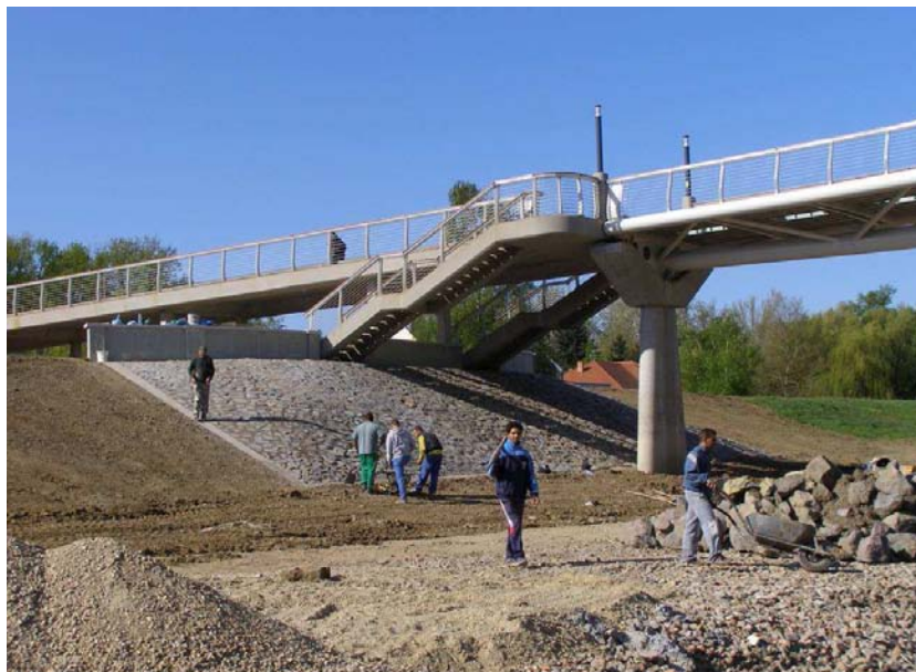
8-4. ábra: Rézsűburkolat építése a bal parton
