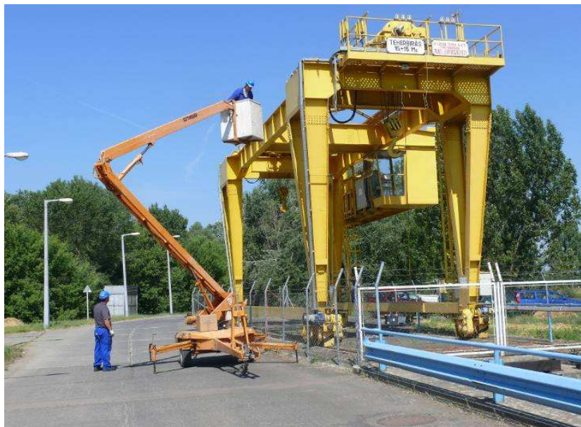
12-4. ábra: Hullámtéri bakdaru helyreállítása
