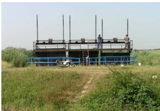
5-17. ábra: NK-III-2. ffcs. vasúti műtárgy javítása
