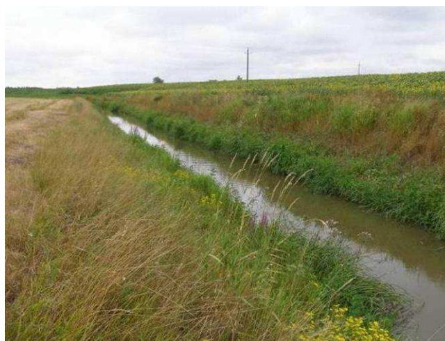
2-15. ábra: A csatorna keskeny medre a defláció és erózió hatásának kitett
