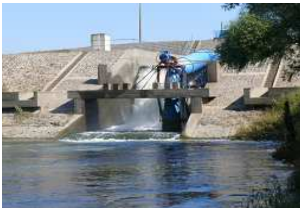
5-7. ábra: Nkfcs. Nyugati-ág 39. jelű műtárgynál beépített vízturbina
