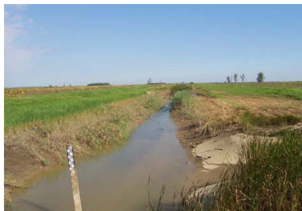
5-18. ábra: NK-III-2. ffcs. rézsűbecsúszás
