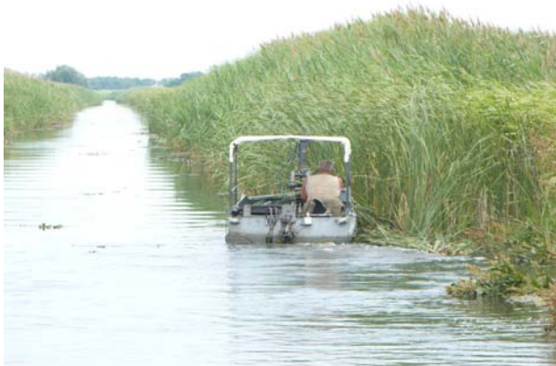
5-19. ábra: NK-III-2. fűrtőcsatorna Truxoros vízinvézyzet irtása
