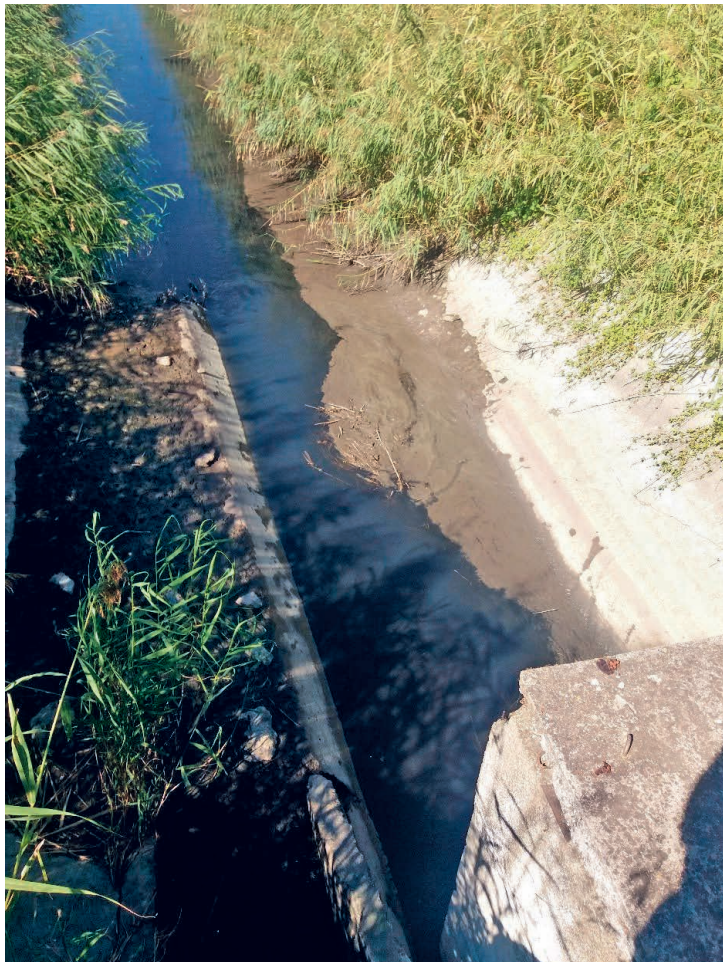
1. kép Ártézi csatorna betorkollása a Tiszába. Kisvíz idején jól látható a feliszapolódás.
