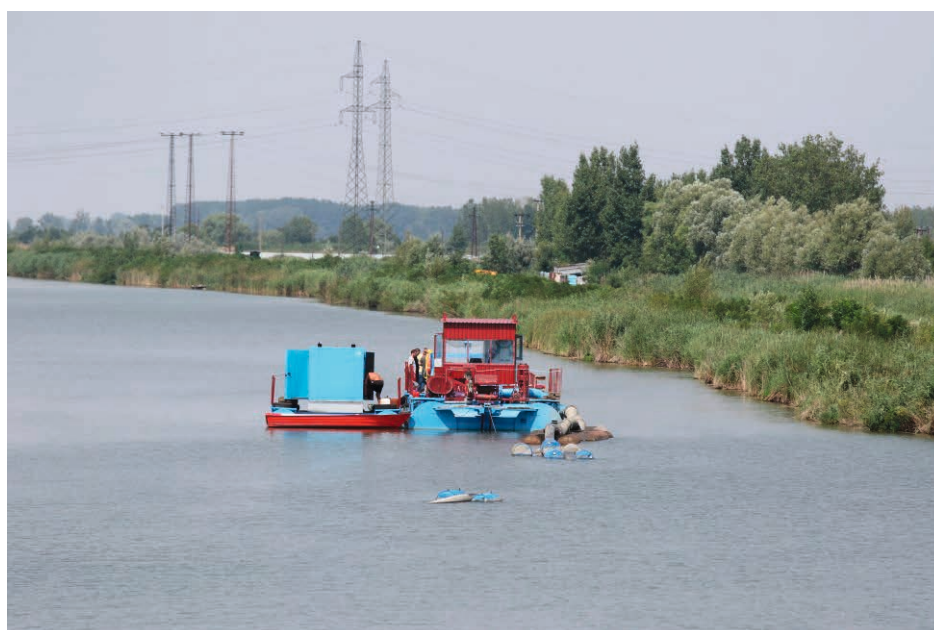
73. kép Kotrás a főcsatornán
