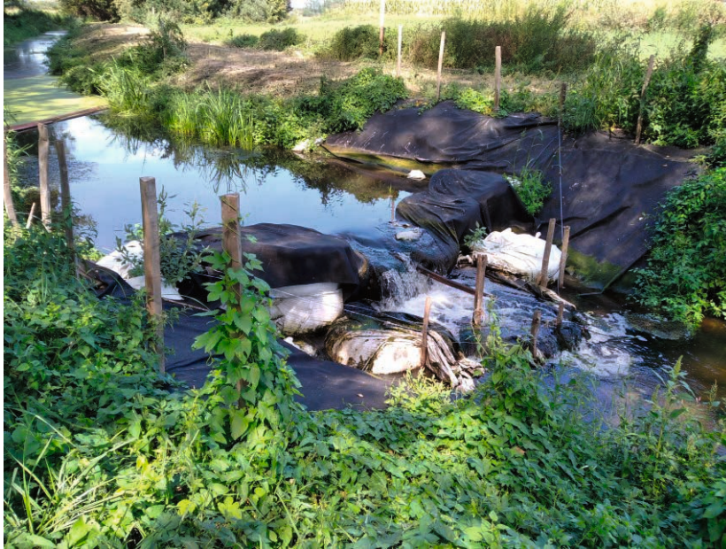
12. kép „Kavicsos” elzárás alkalmazása az albertirsai szennyvíztisztító telep bevezetési pontja alatt
