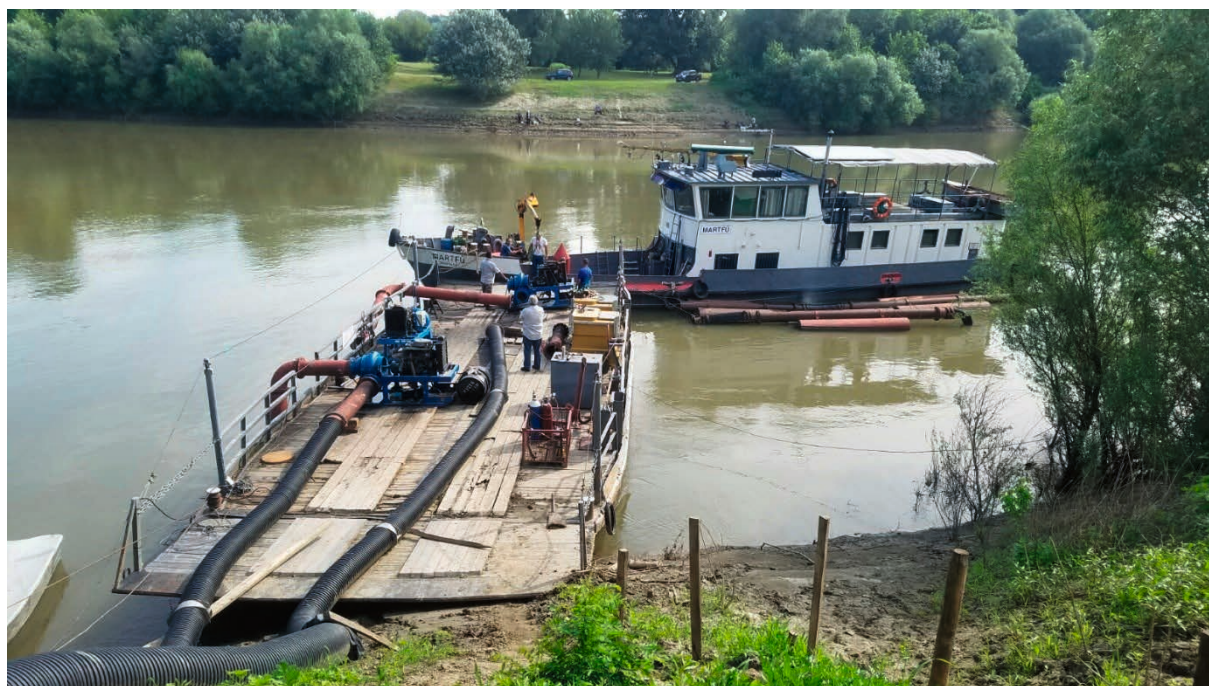
26. kép Tiszavárkonyi provizorium építése
