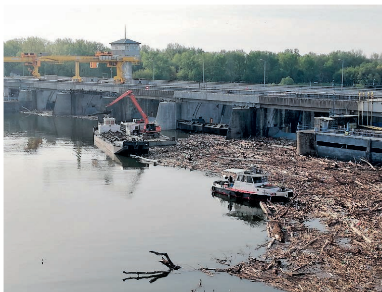
32. kép A Kiskörei vízlépcső felvízéről a hulladék kitermelése
