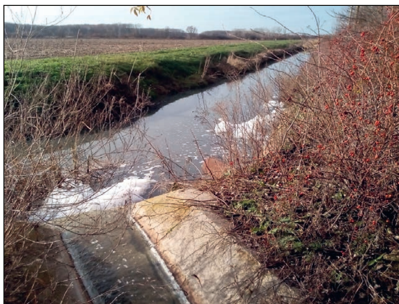
39. kép A Kisújszállási szennyvíztisztító telep bevezetésénél habzás 2020.01.06.
