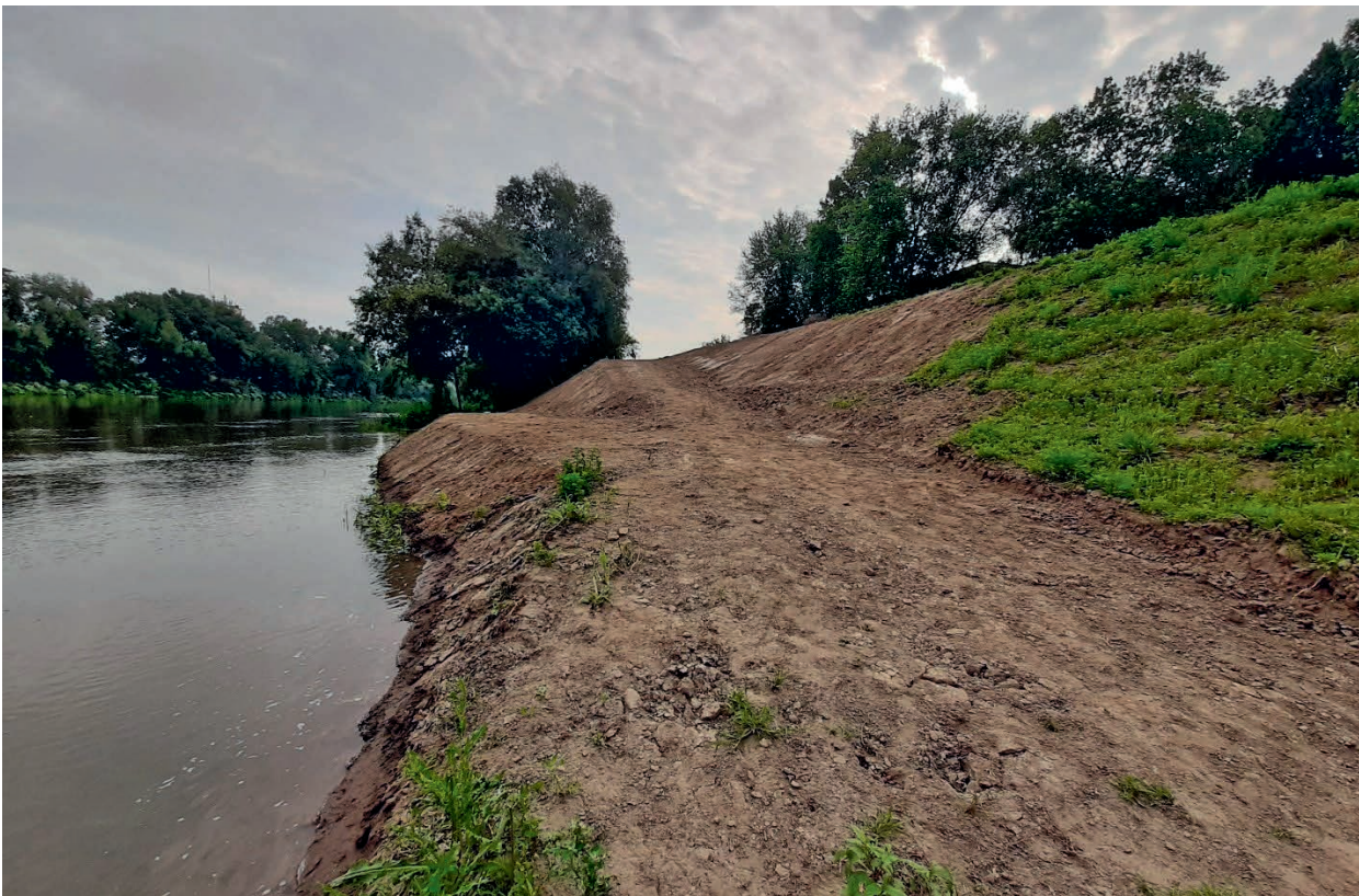
17. kép Közlekedő rámpák kialakítása gépi földmunkával
