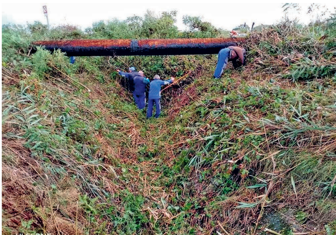
59. kép Tégláslaposi belvízesatorna tisztítása októberben
