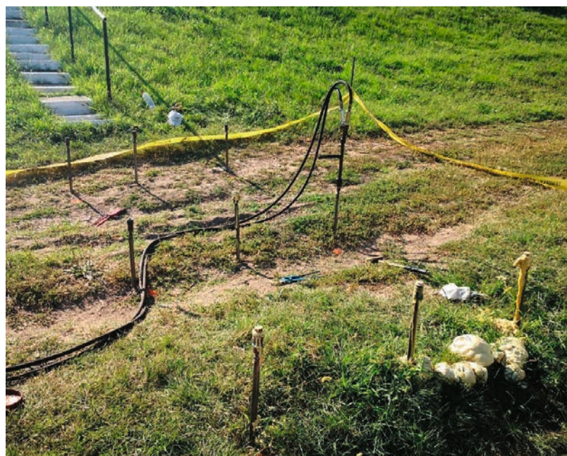
22. kép Álomzugi zsilip kiinjektálása 2020.08.29.
