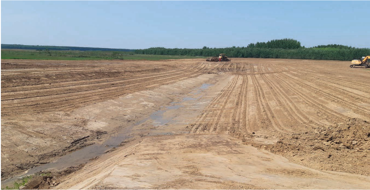
19. kép Bivalytói beszakadás helyreállítása
