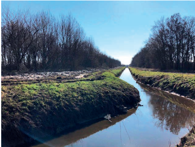
31. kép A Kisújszállási XXIX Északi-ág csatorna torkolati szakasza a kotrást követően
