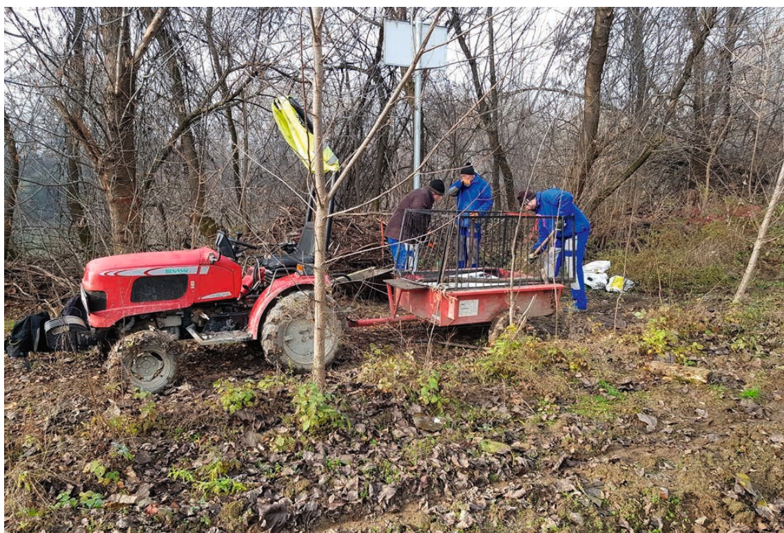
66. kép 18.3.7. A telepítéshez szükséges eszközök és anyagok kijuttatása és előkészítése (betonkeverés kézzel) sok esetben igen nagy kihívást jelent
