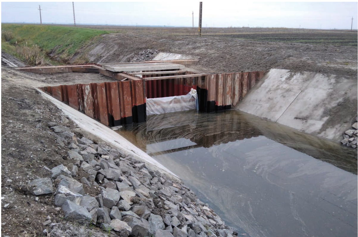
45. kép Vízvisszatartó műtárgy építése
