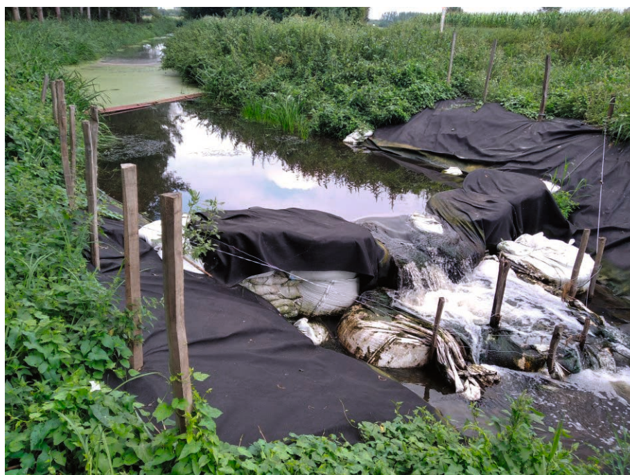
35. kép Gerje főcsatorna mederelzárás
