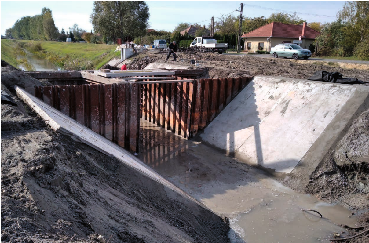
44. kép Vízvisszatartó műtárgy építése
