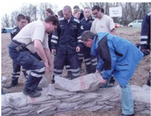
6. sz. képcsoportok: A buzgár ellennyomó medencéjének kiépítése
