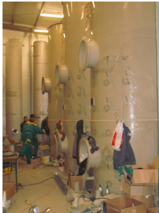
KOI szűrők a beépítés során
