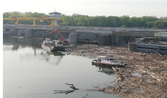
Uszadék és kommunális hulladék kiemelése és uszályba rakodása a Kiskörei Vízlépcső előtt
