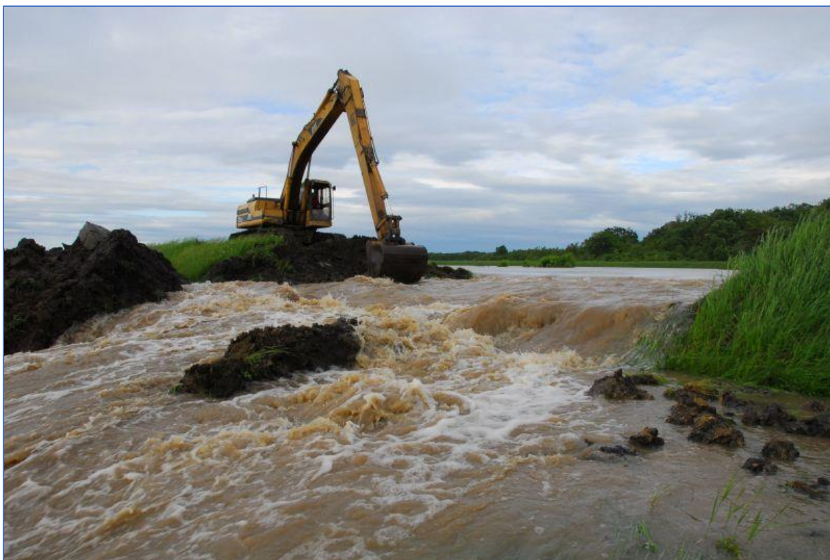
4. fotó: Tározónytás a Zagyván Jászteleknél (2010) forrás: KÖTIVIZIG
