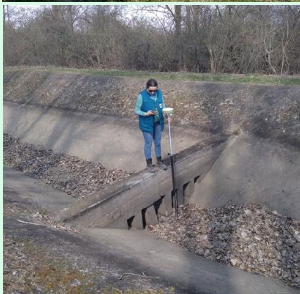
Meglévő AC tápcsatorna és a Kontai öntözőcsatorna felmérése
