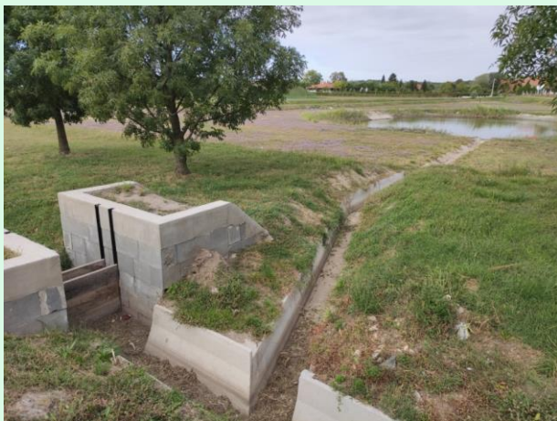
Csapadékvíz tározó Törtelen
